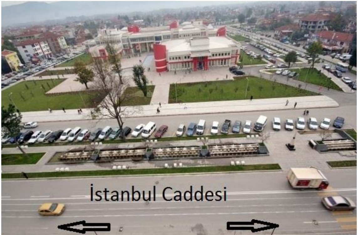
Şekil 4.5. Valilik Binası çevresinde bulunan otopark.
