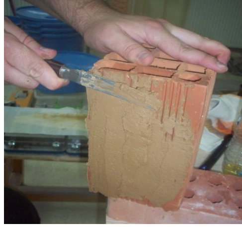
Şekil 3.11. Sıvanın tuğla yüzeye uygulanması.
