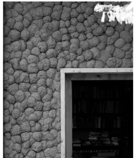
Şekil 2.6. Fırlatma sıva uygulaması (Minke 2009).
