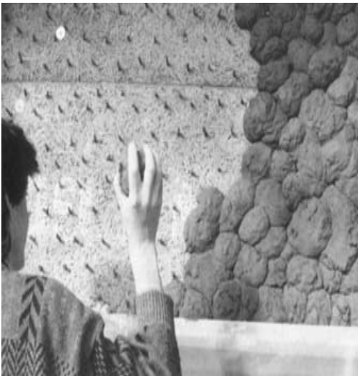
Şekil 2.5. Kil toparlarının bambu dübellere sabitlenmesi (Minke 2009).
