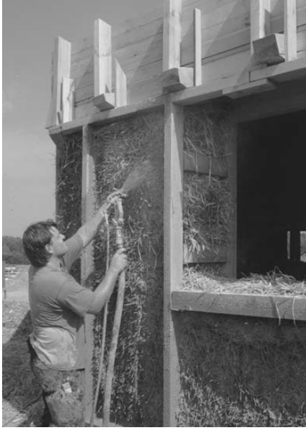
Şekil 2.7. Saman balyaların püskürtme kil sıva ile sabitlenmesi (Minke 2009).
