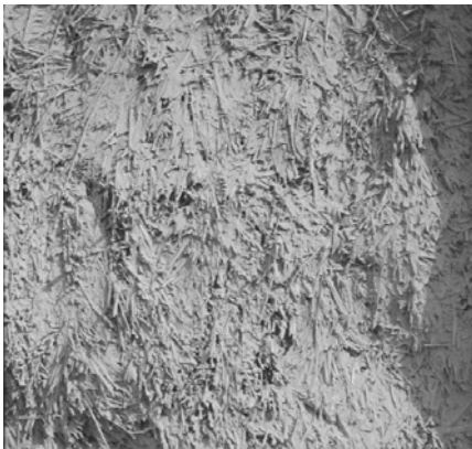
Şekil 2.8. Saman balyalı sıva yapılmış duvar (Minke 2009).
