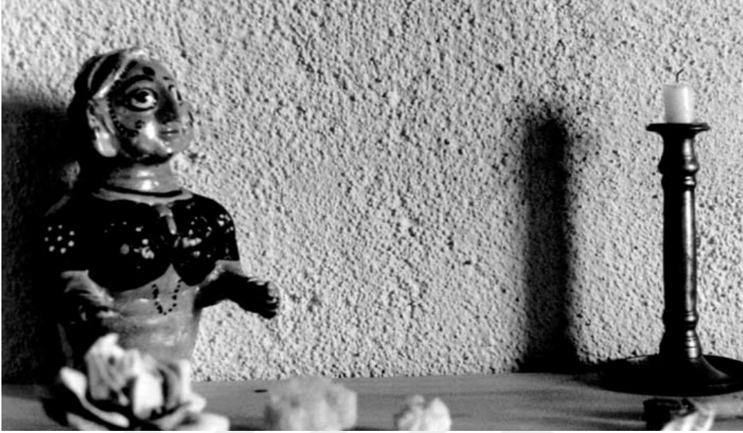
Şekil 2.4. Mineral kil sıva ile sıvanmış duvar örneği (Minke 2009).
