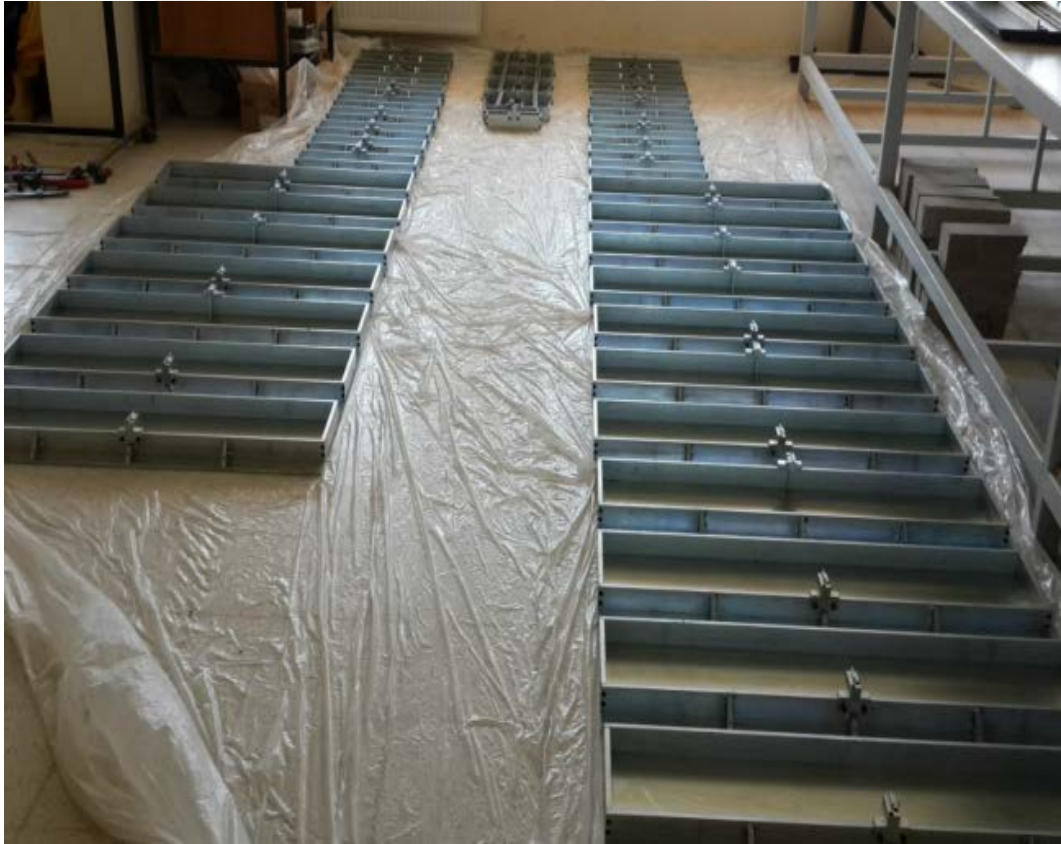
Şekil 2.2. Kırılma testi için üretilen kalıpların döküm öncesi görünümü
