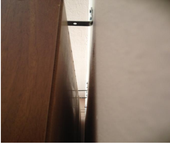
Fotoğraf 16 -Dolapların Depreme Karşı Duvara Sabitlenmesi 31 Mart 2014
