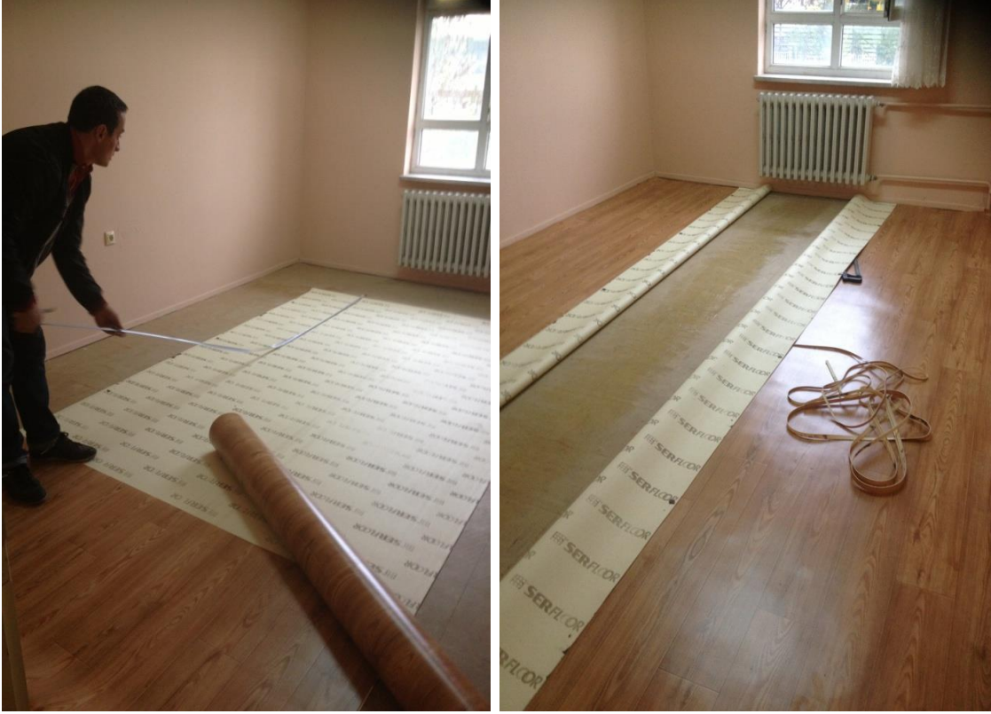
Fotoğraf 9 -Atölye Zeminine Mineflo Döşemesinin Yapılması 22 Kasım 2013
