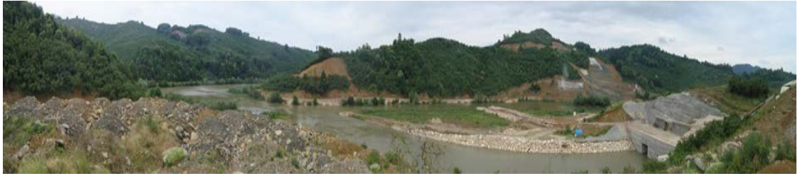
Şekil 4.36. Gözlem noktası 27, baraj inşaatı görüntüsü
