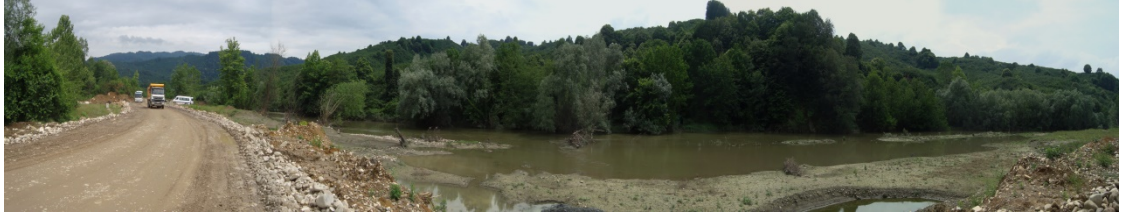
Şekil 4.35. Gözlem noktası 26, baraj inşaatı görüntüsü
