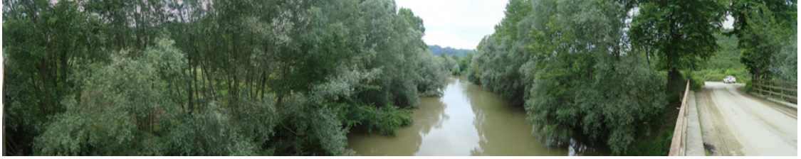
Şekil 4.43. Gözlem noktası 28, Aydoğan köprü üzeri
