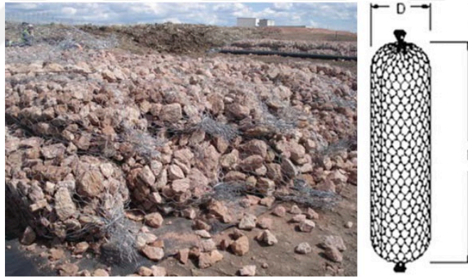
Şekil 2.24. Gabion Torbaları Detayı(Anonim 2015d)
