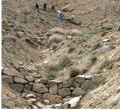
Şekil 2.27. Kuru duvar eşikler (Anonim 2015e).
