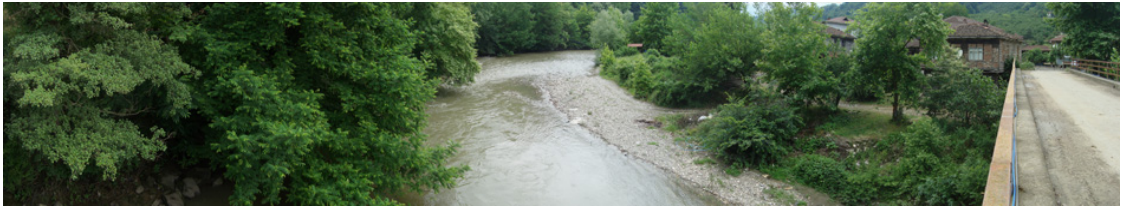
Şekil 4.41. Gözlem noktası 24, Beyler köyü köprü üstü, üst havza
