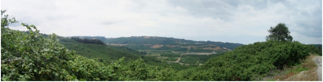
Şekil 4.40. Beyler köyü yolu baraj inşaatı görüntüsü
