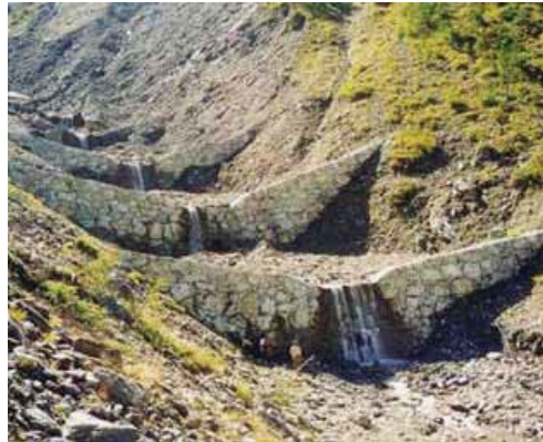
Şekil 2.26. Miks eşikler ve harçlı duvar eşikler
