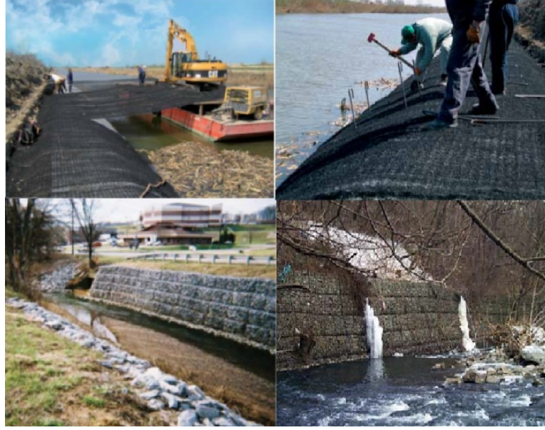
Şekil 2.25. Akarsu kenarı gabion detayı (Anonim 2015c)
