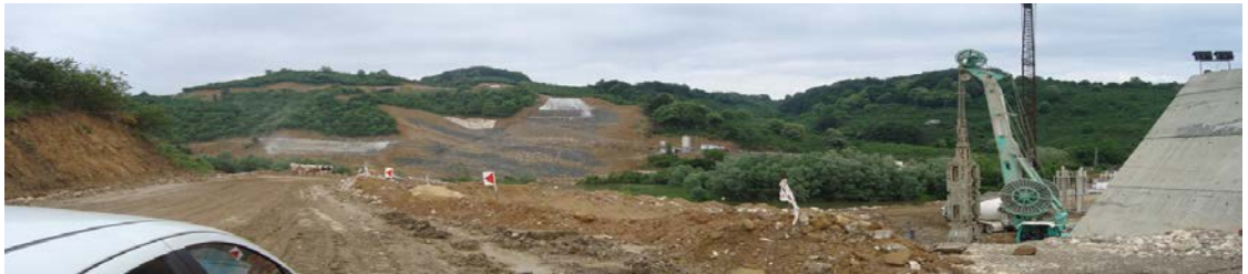
Şekil 4.37. Gözlem noktası 20, baraj inşaatı alanı görüntüsü
