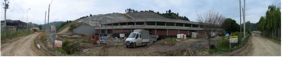
Şekil 4.38. Baraj inşaatı alanı görüntüsü
