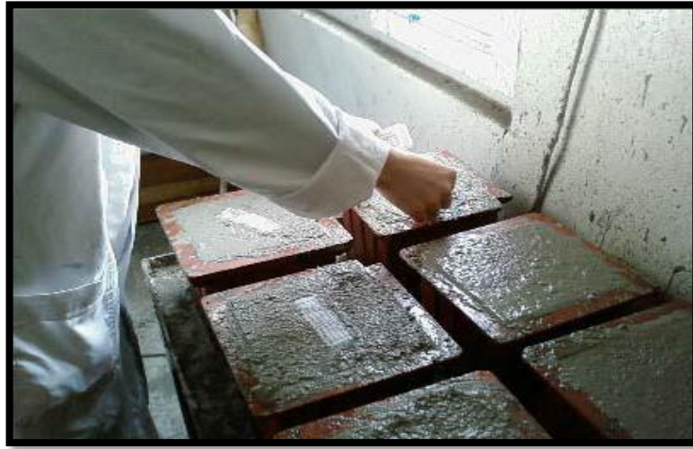
Şekil 3.10. Beton karışımının kalıplara yerleştirilmesi.
