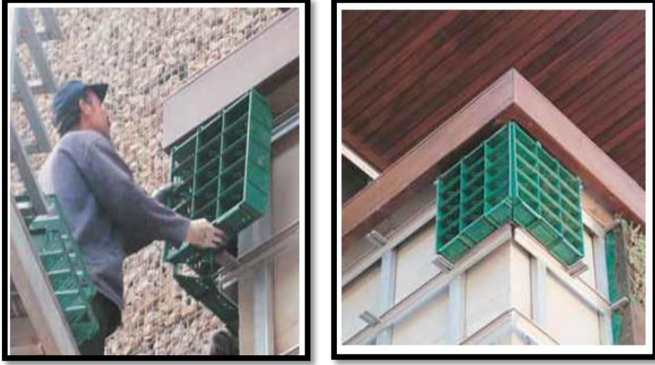
Şekil 1.31. Panel modüler sistem montajı (Erdoğan ve Khabbazi 2013).
