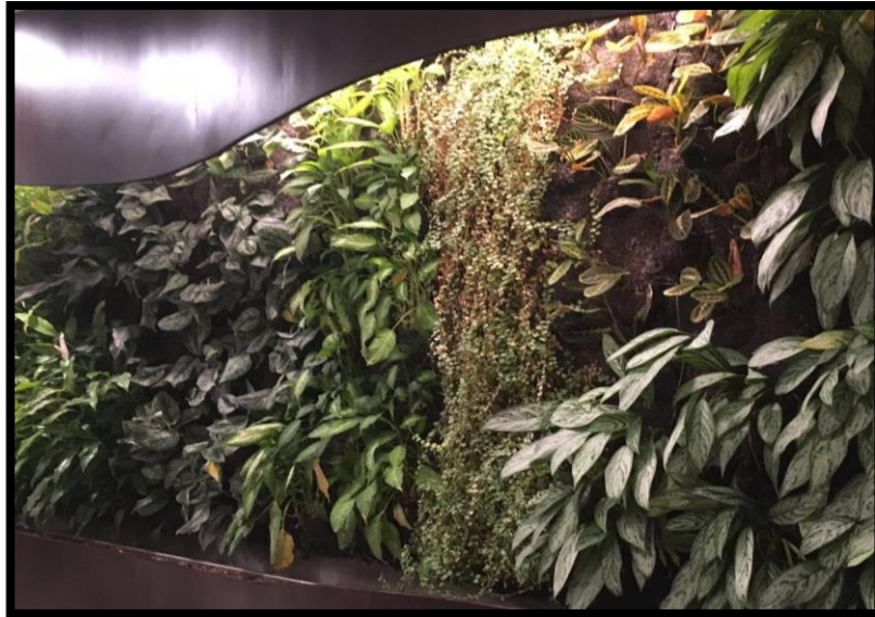
Şekil 3.27. Skyteam Lounge dikey bahçesindeki susuzluk belirtileri.
