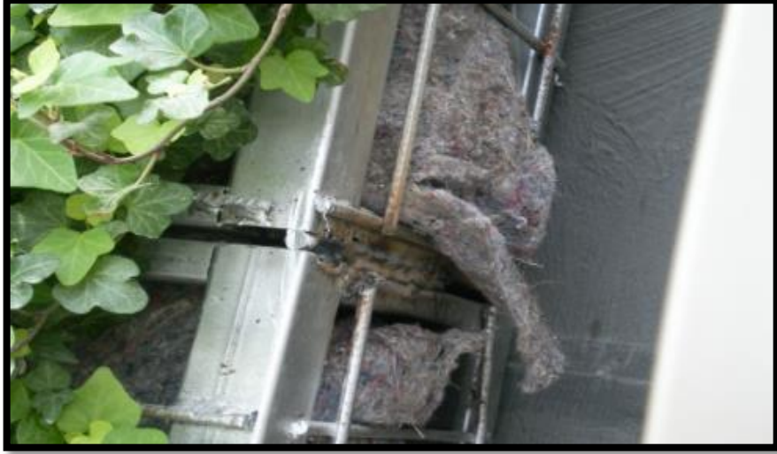
Şekil 3.13. Brandium Alveriş Merkezi'nde keçe, 40x40 profil ve 15x15x6 mm çesan demirden oluşturulan dikey bahçe konstrüksiyonu.
