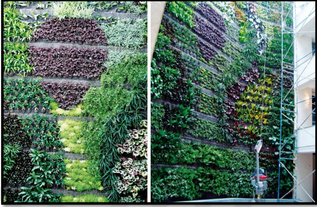
Şekil 3.12. Armaggan Sanat Merkezi dikey bahçe keçe sistemi (Abalı 2016).
