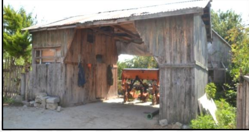
Resim 3.30. Hüseyin Kıl mahallesi bahçe giriş kapısı.
