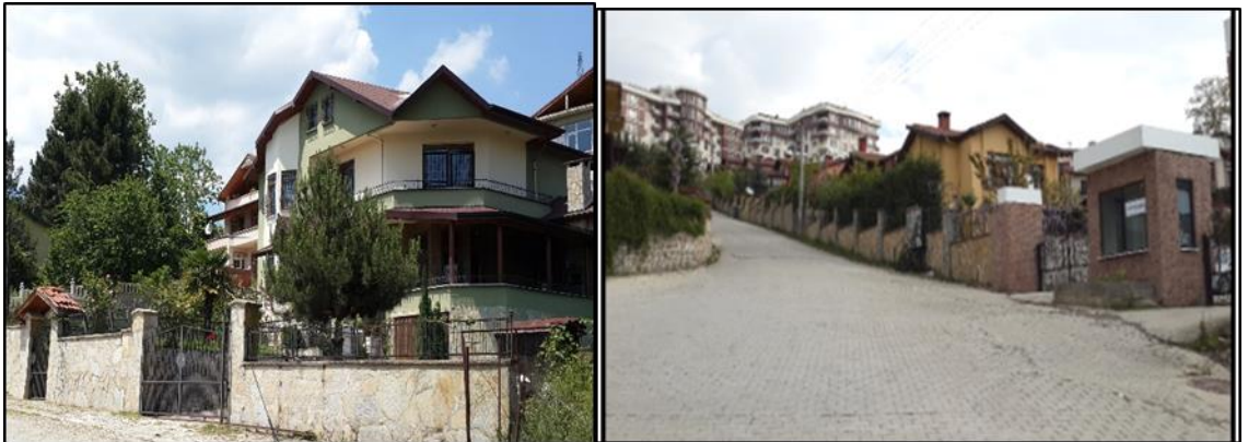
Resim 3.26. Murat Demir mahallesi villa bahçe duvarları.
