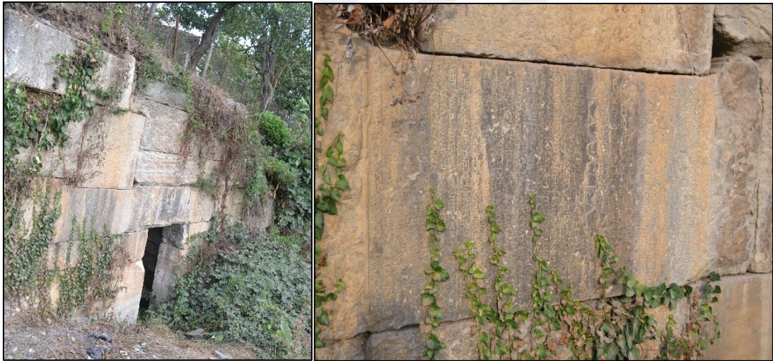
Resim 3.7. Terzialiler Mahallesi Batı Surları.
