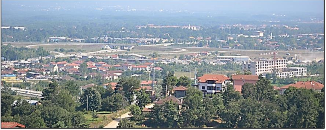
Resim 3.42. Bayram Gökmen mahallesinde yurt inşaatı.
