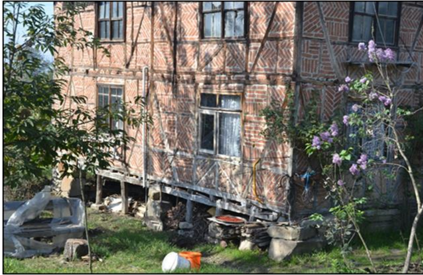
Resim 3.13. Tuğla dolgulu ahşap karkas sistem.
