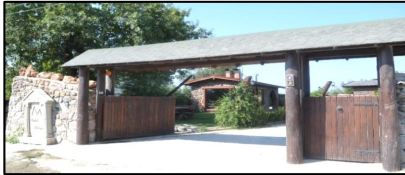
Resim 3.28. H. Kıl, K. Işıldak mahalleleri bahçe giriş ve duvarlarından örnekler.
