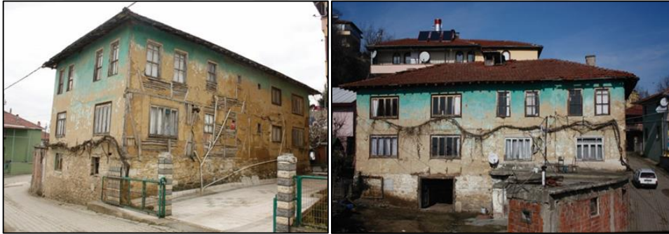
Resim 3.12. Tescilli yapının doğu ve güney cephelerden görünüşleri.
