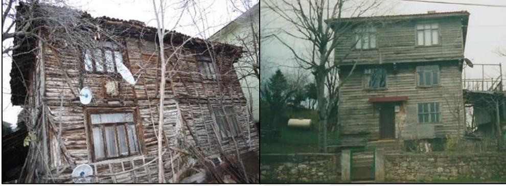
Resim 3.14. Dizeme tekniği ve ahşap cephe kaplaması örneği (Anonim 2014d).
