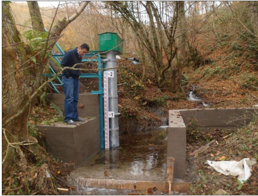
Şekil 2.9. Yukarıkaraköy havzasında dere kesitinin beton duvarla düzeltilmesi.
