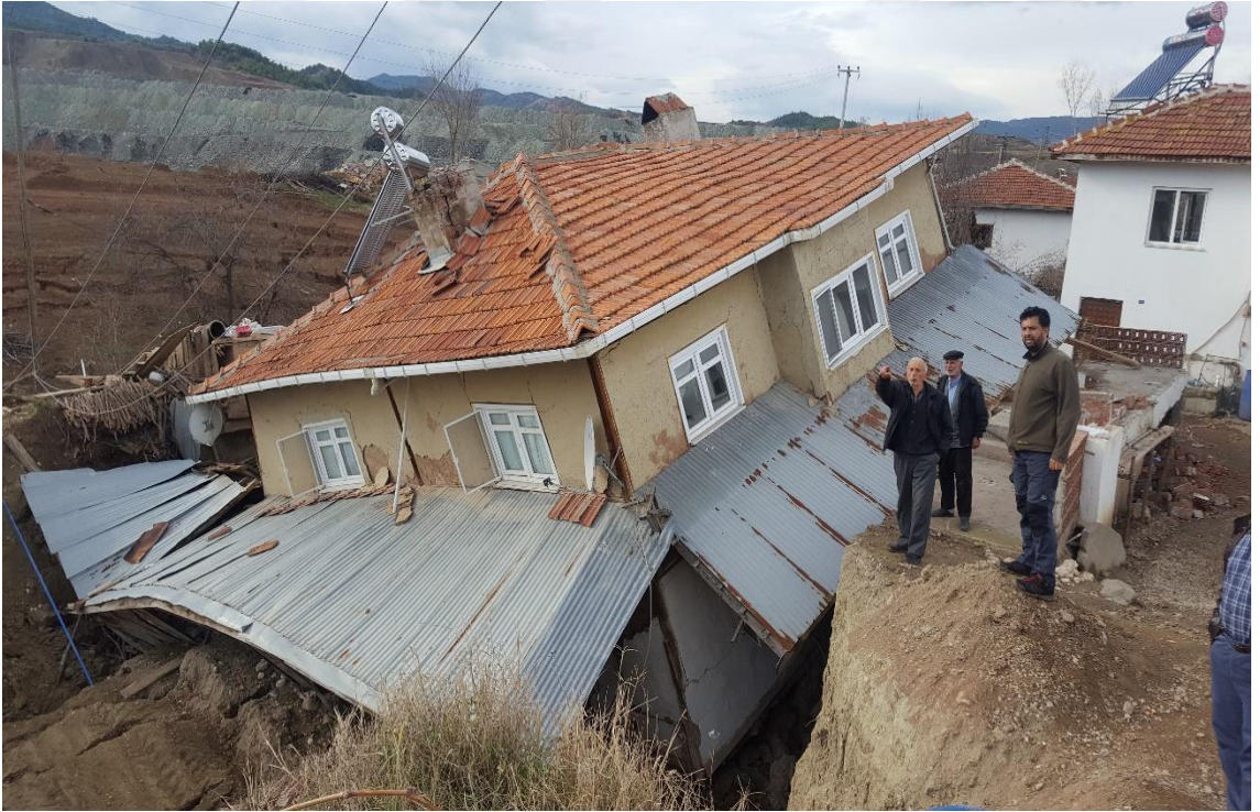
Şekil 2.5. Heyelan sonucu yıkılan bina.
