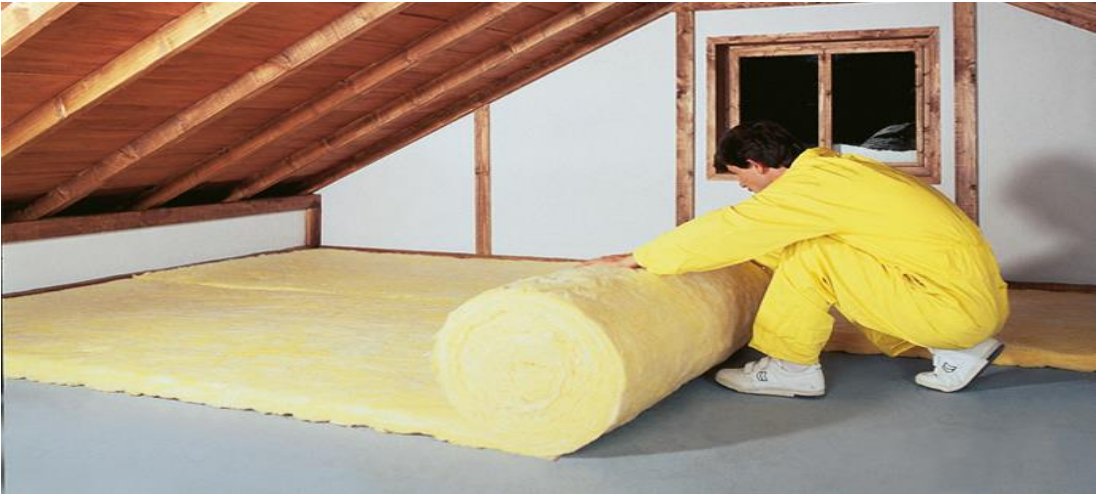
Şekil 3.3 Cam yünü tavan arasına uygulama şekli.
