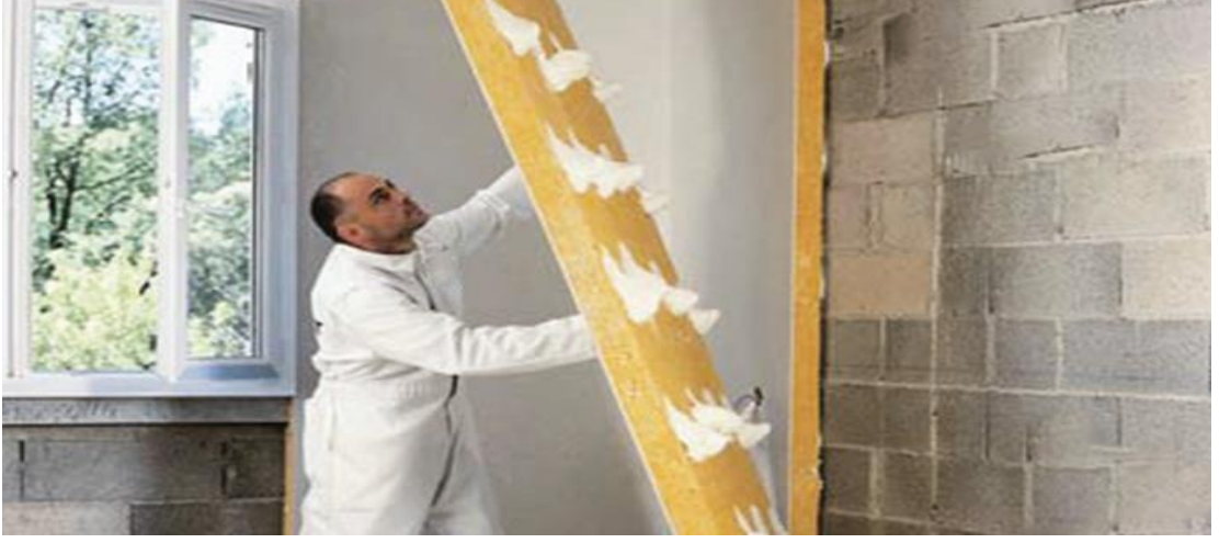
Şekil 3.4 Cam yünü levha duvara uygulama şekli.
