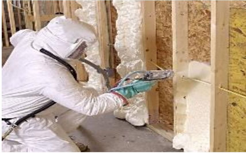
3.12 Sprey poliüretan köpük uygulaması.
