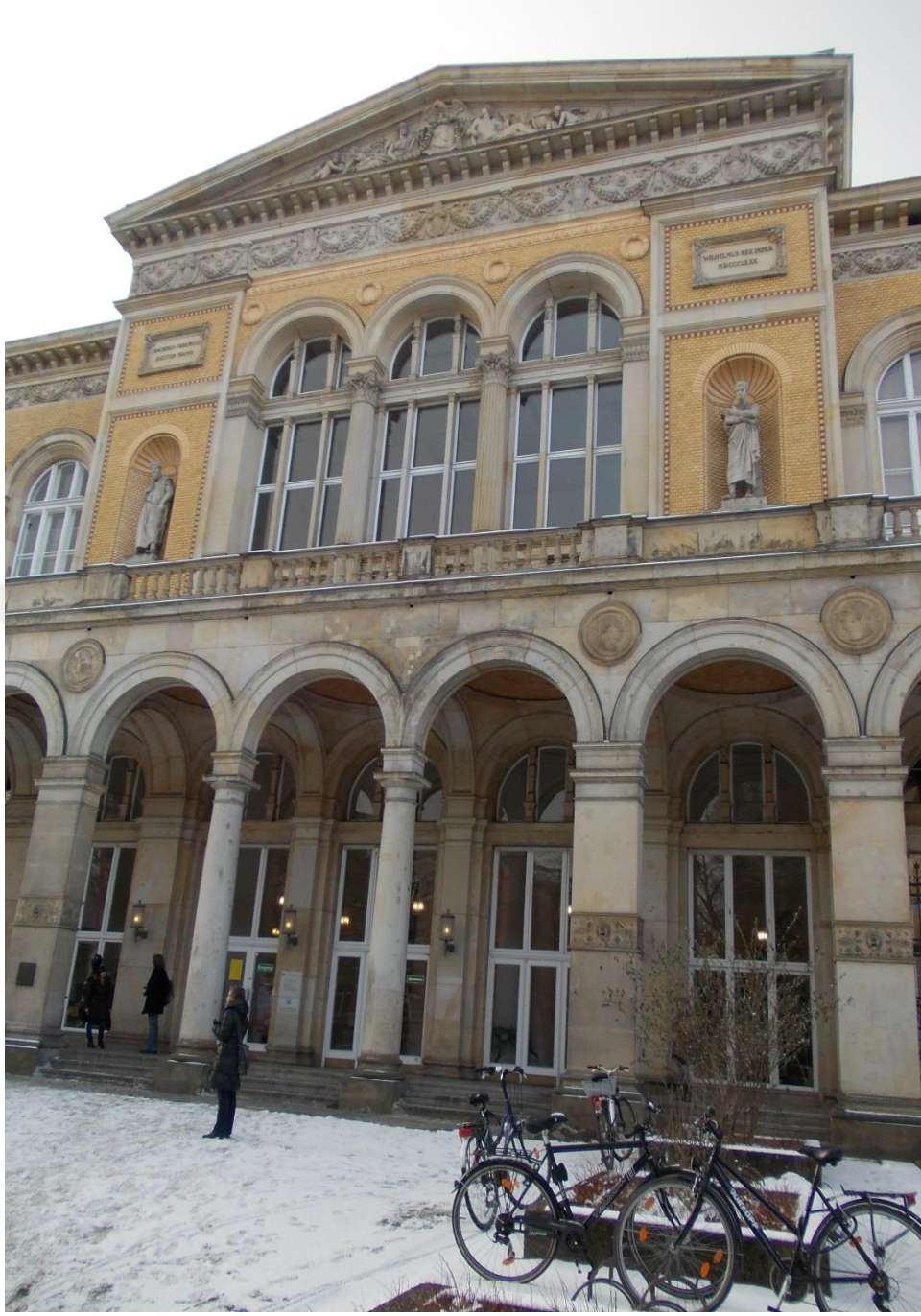
Fotoğraf 10: Berlin Gzel Sanatlar niversitesi - Hans-Wolfgang Nickel'in grev yaptığı ve emekli olduėu bina (Fotoğraflar 03.02.2011 tarihinde arařtırmacı tarafından çekilmiřtir).
