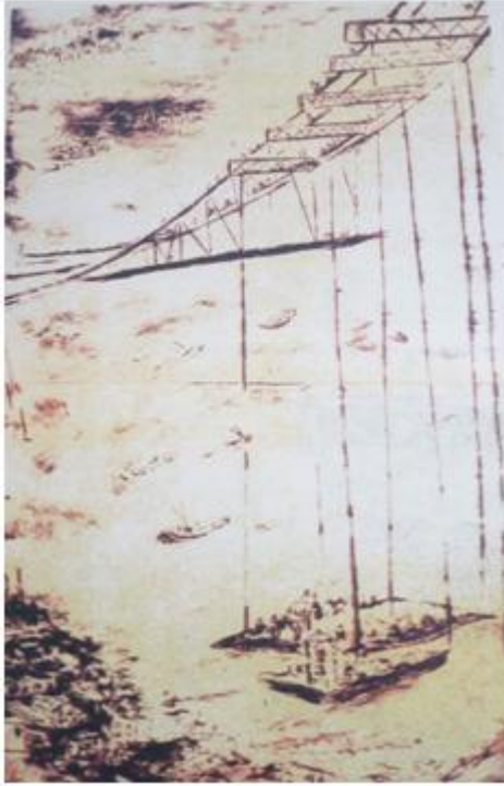
Görsel 62. Boğaz Köprüsü Yapılırken, 1974
