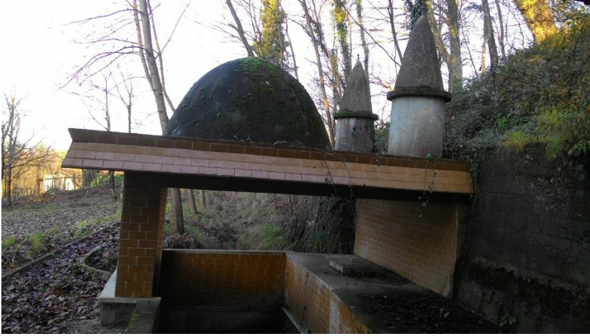
Türbede kaynağı bulunamayan su çeşmesi
