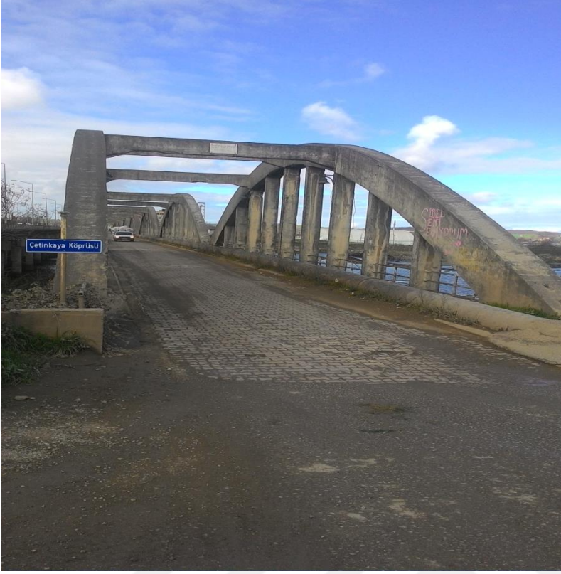
Bafra, Fatih Mahallesi, “Çetinkaya Köprüsü” (2.3.2.1.)
