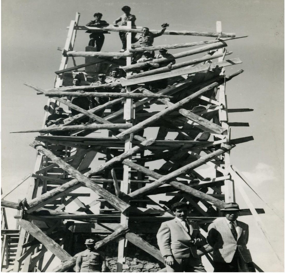
Ek-4: Kop Şehitliđi Anıtı İnşaatı
