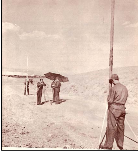
Nivelman Çalışmalarından Bir Görünüş ve Wild N3 Nivelman Aleti 199
