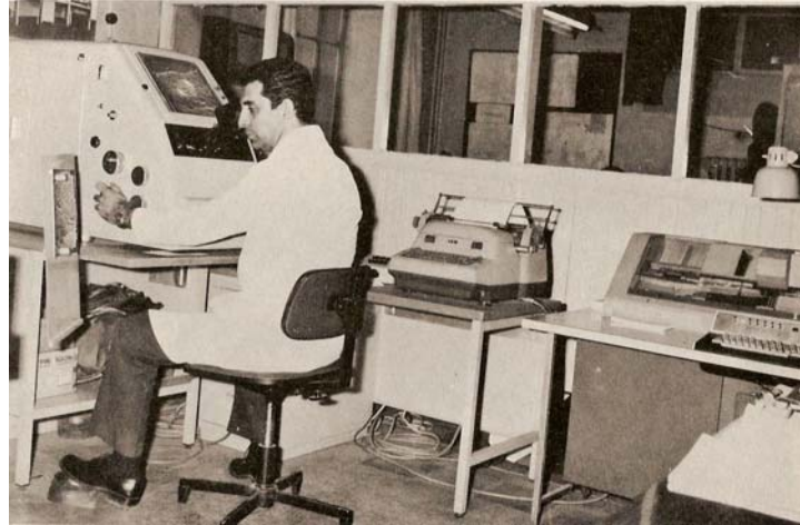
Zeiss Stereo Komparator Aletiyle Fotogrametrik Nirengi Çalışmaları Yapılırken 231
