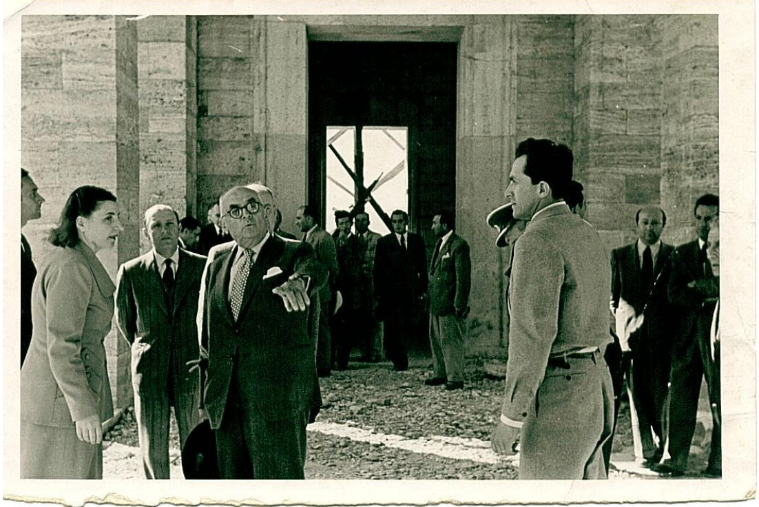
Cumhurbaşkanı Bayar, Anıtkabir İnşaatı Kontrol Mühendisi Sabiha Güreyman ile İnşaatı Kontrol Ediyor.
