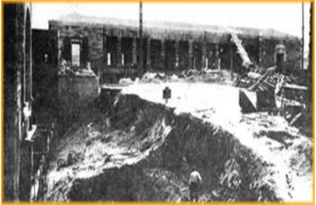
Mozole önü merdivenlerinin yapımı öncesi
