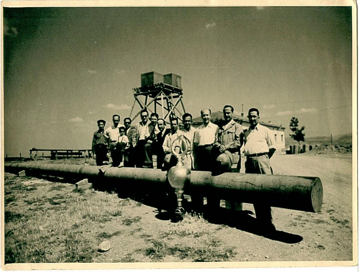
EK-11: ABD'den gönderilen bayrak direğini Anıtkabir inşaat alanında gösteren fotoğraf
