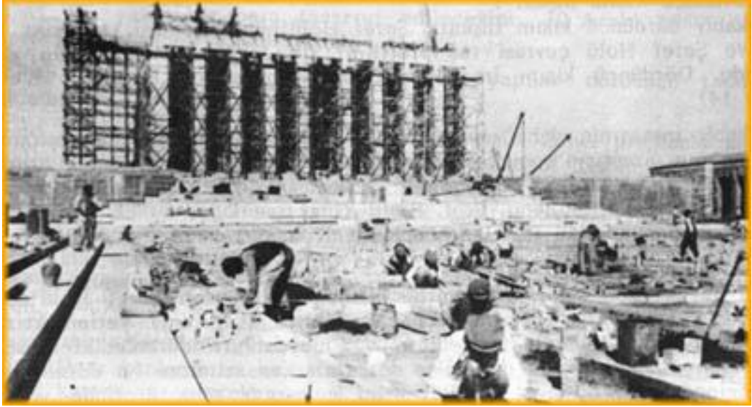
Tören alanı taş kaplama işleri ve Mozole İnşaatı
