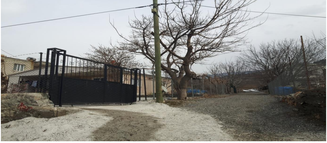
Şekil 3.13: Pozantı İlçesi Gökbez Mahallesi konut ve yol yapısı
