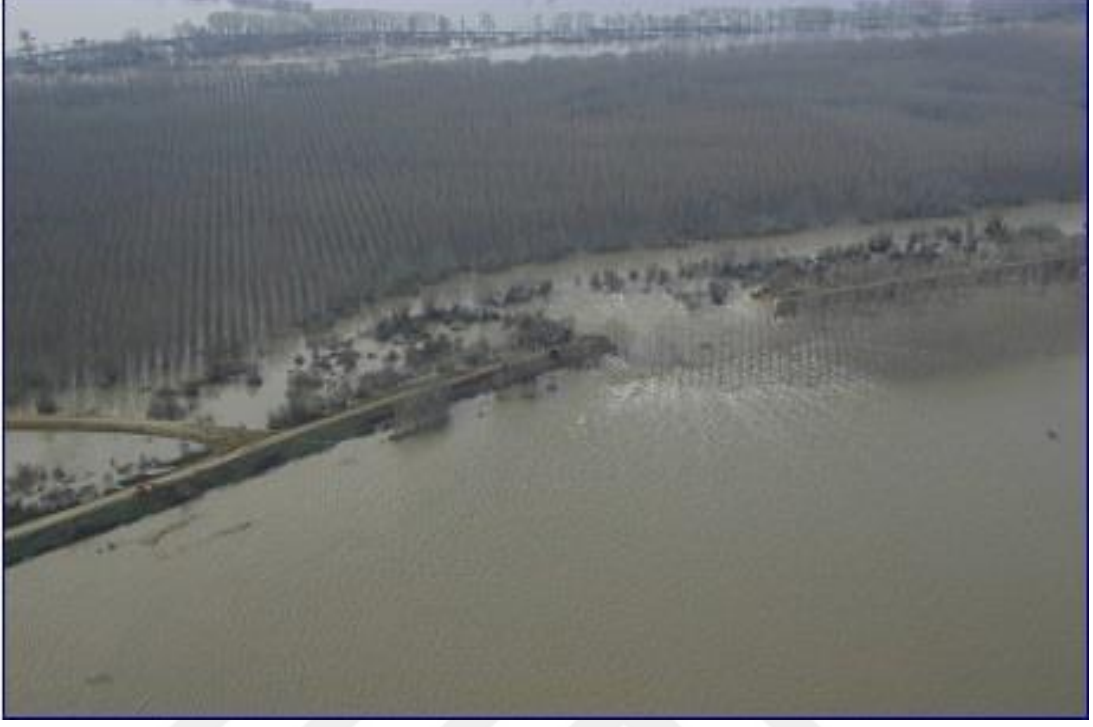
Şekil 5.20: İpsala taşkın önleme kış setinde meydana gelen yarıлма.
