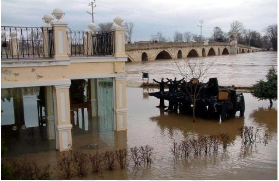
Şekil 5.22: 2006 yılı taşkınında Meriç Nehri Protokol Evi Çay Bahçesi.
