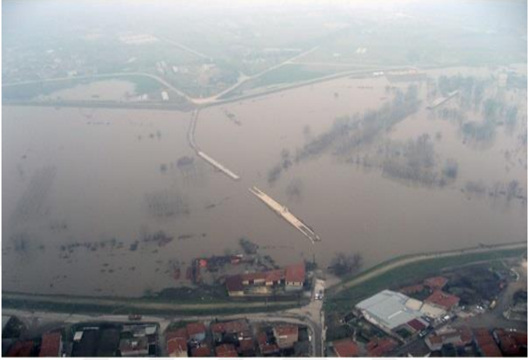
Şekil 5.35: 2010 yılı taşkınında Tunca Köprüsü, Merkez, Sarayıçi Mevkii.
