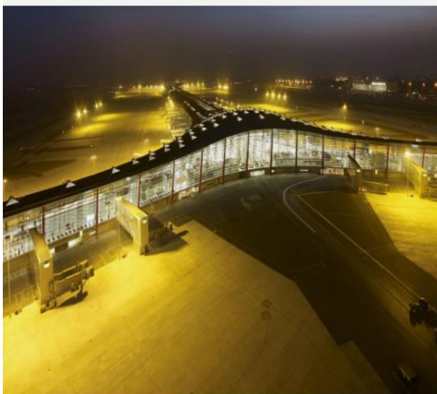
Şekil 2.6: Beijing Airport, T3 Terminali, Çin
