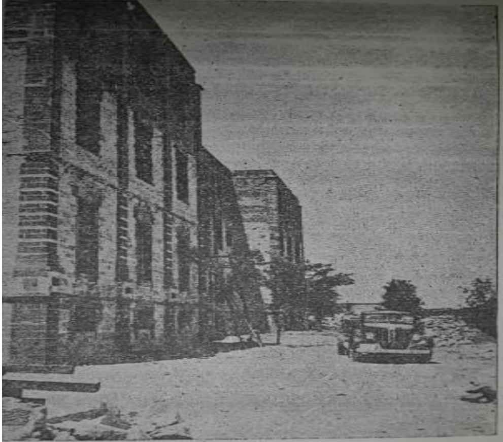
Yeni yapılan Nümune Hastanesi
