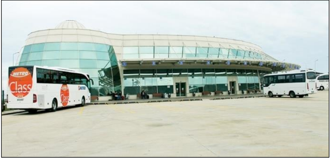
Şekil 3.5.2: Ünye Otobüs Terminali'nden bir görünüm
