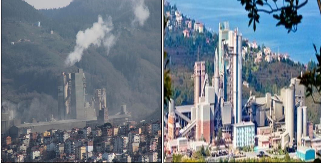
Şekil 3.3.2: Araştırma alanında bulunan Ünye Çimento Fabrikasından bir görünüm
