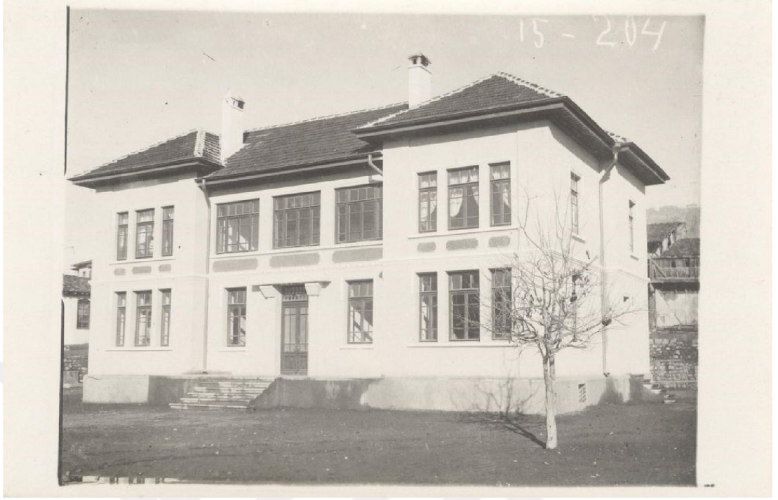
EK-4 Halkevi Binası
