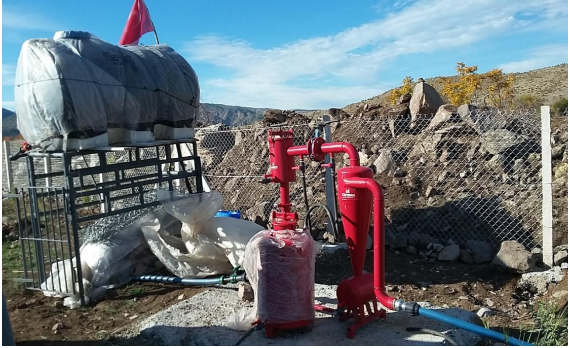
Şekil 4.39 Korgun Merkez % 50 hibe destekli tarla içi kontrol ve filtreleme sistemi
