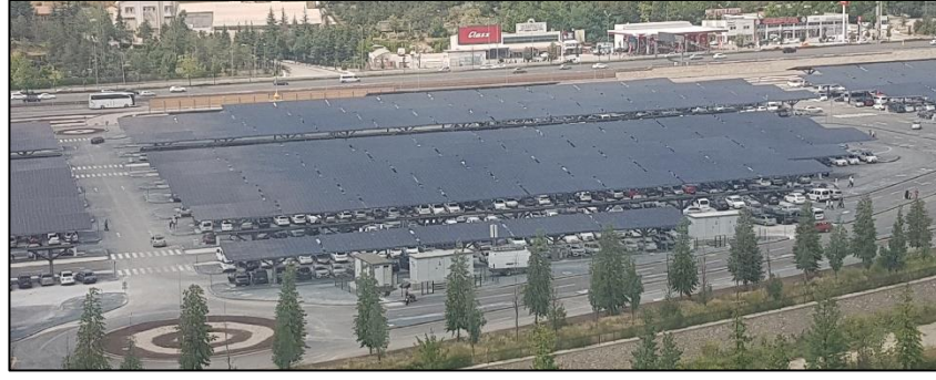
Şekil 3.14.1 Ankara Woderland (Ankapark) oto parkına kurulmuş güneş enerji sistemi
