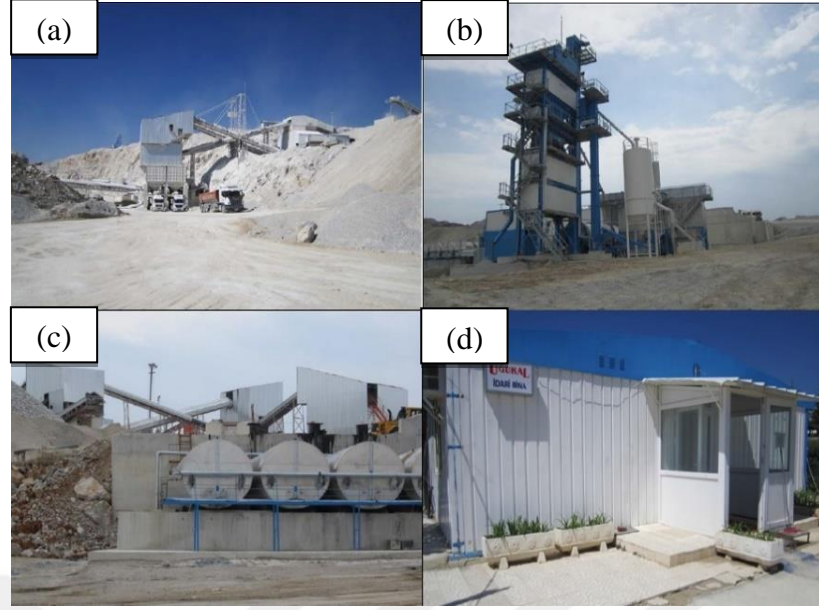
Şekil 4.3 Proje sahasında yer alan tesisler (a) kırma eleme tesisi (b) asfalt plenti (c) mekanik plent (d) idari bina (Anonim 2013)
