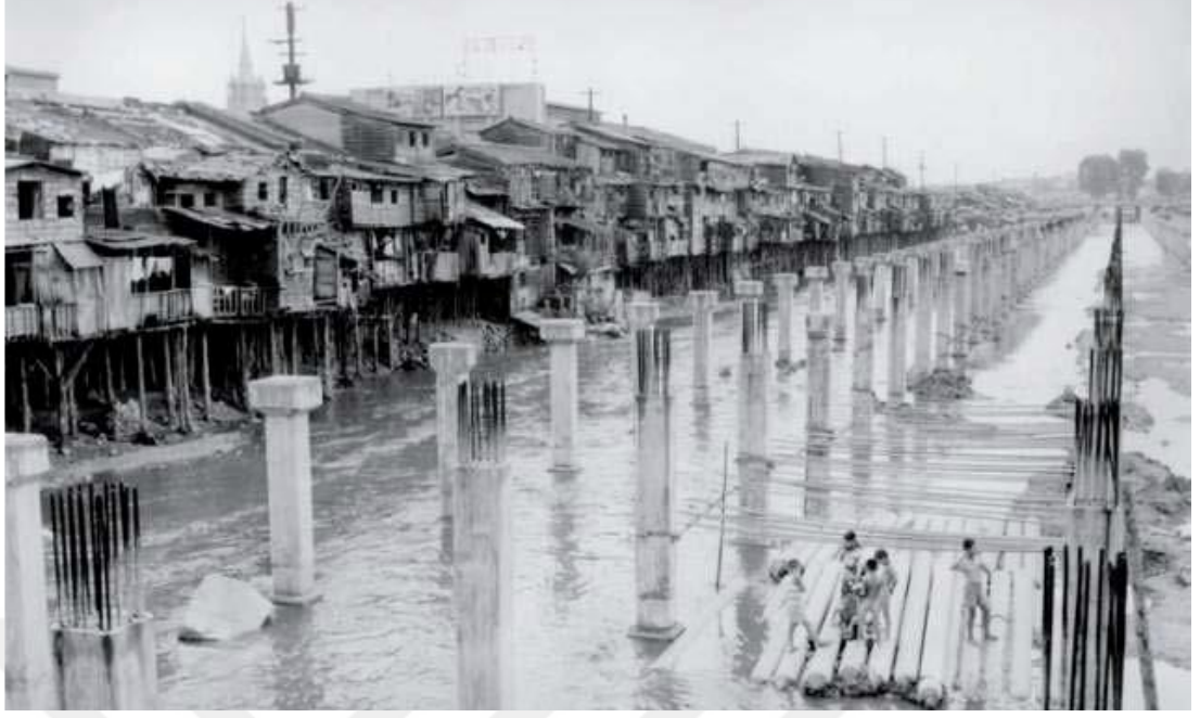
Şekil 2.26 Cheonggyecheon nehri üzerine beton dökülerek kapatılması ve yükseltilmiş otoban inşasından bir görüntü (Lee 2006)
