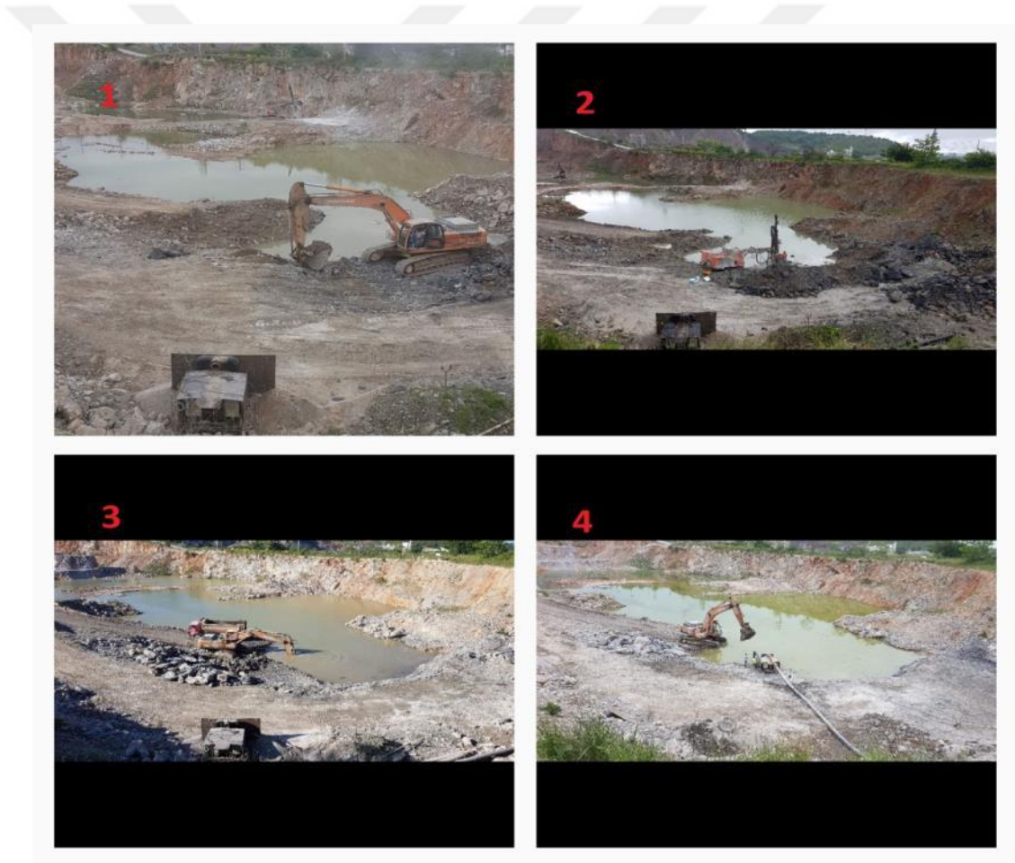
Şekil 5.3: Ocak İçi Suyu 1. Kısım Tahliye Çalışması İşlem Sırası Görüntüsü.
