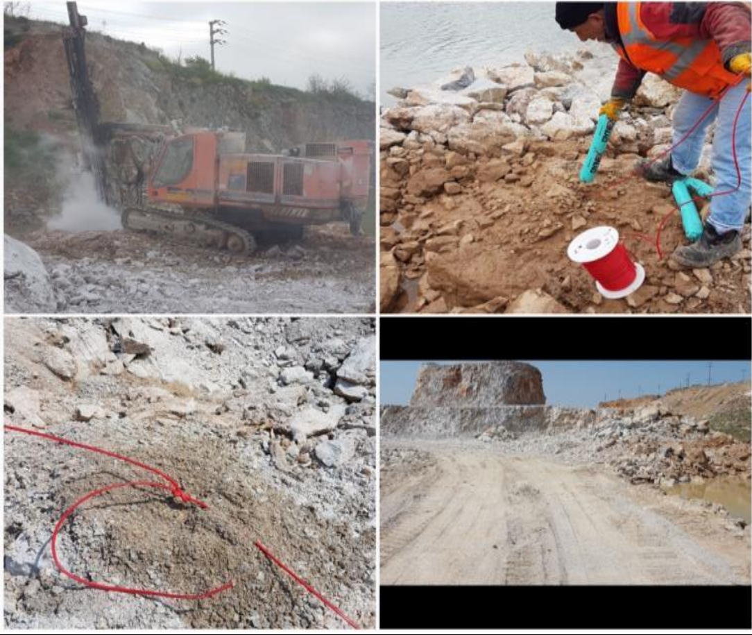
Şekil 5.15: Patlatma Bölgesi-5 (Rock Delici, Deliklerin Doldurulması, Fitol Bağlantı, Patlatma Sonrası Alan).
