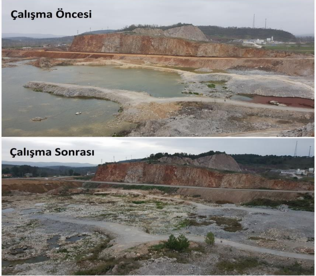
Şekil 5.6: Madenin Su Tahliye Çalışması Yapılmadan Önceki ve Sonraki Hali.
