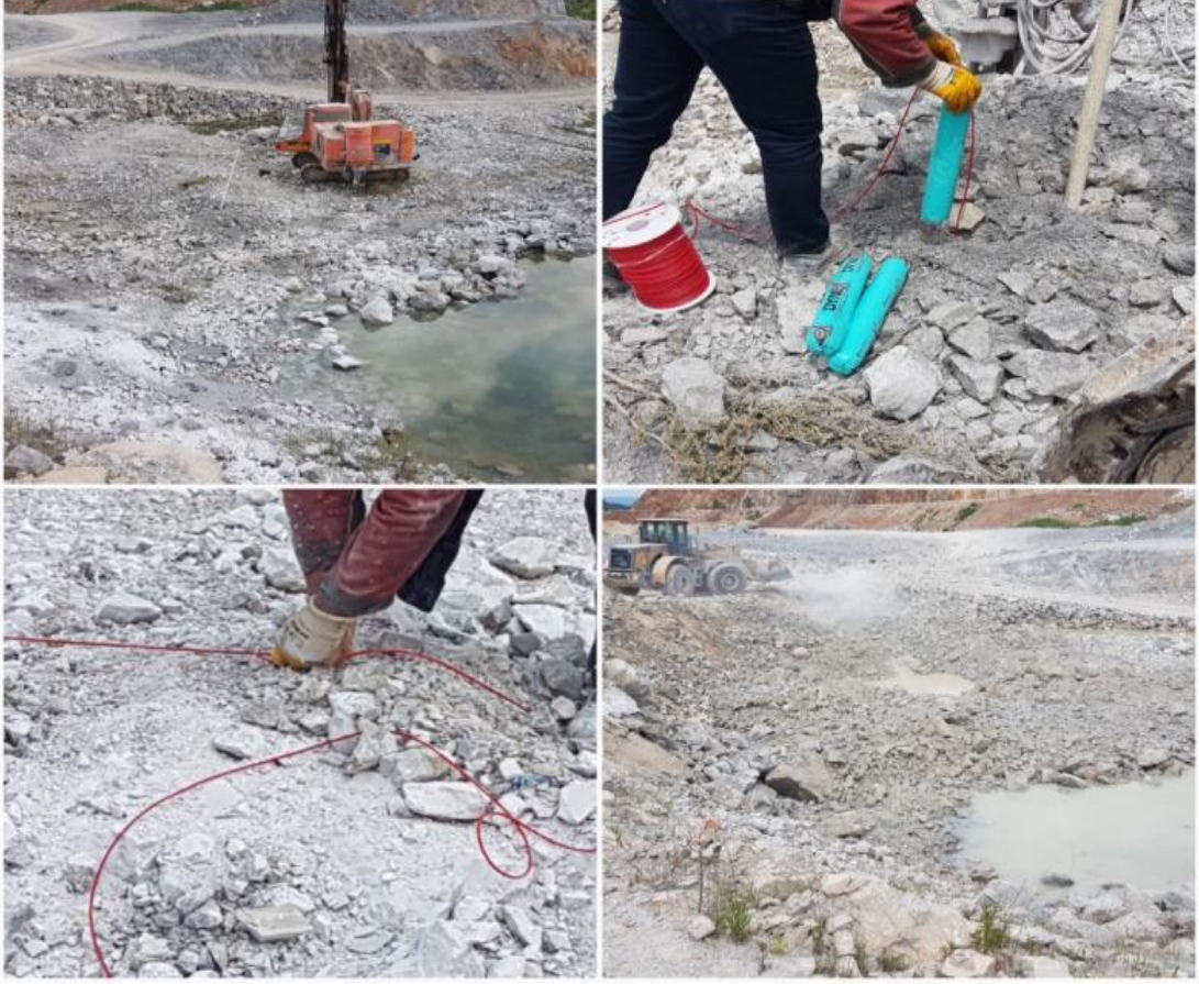
Şekil 5.16: Patlatma Bölgesi-6 (Rock Delici, Deliklerin Doldurulması, Fitol Bağlantısı, Patlatma Sonrası Alan).
