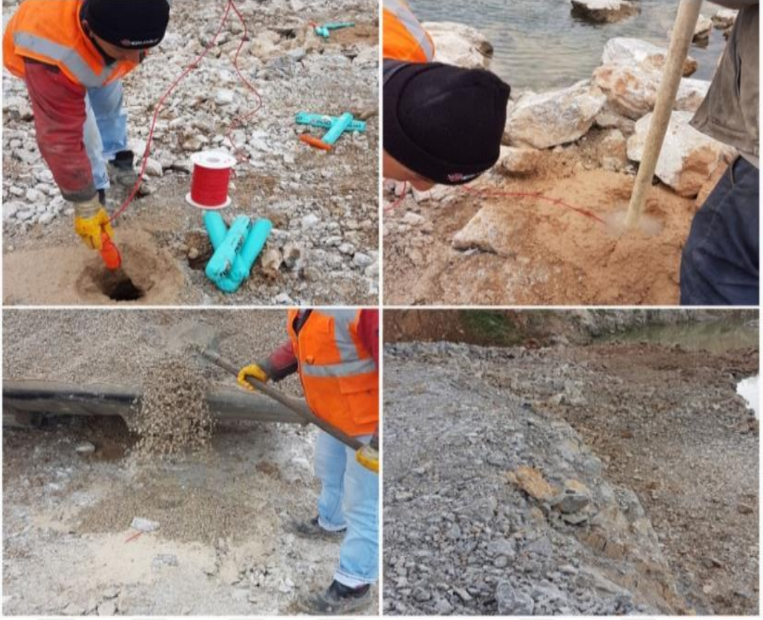
Şekil 5.13: Patlatma Bölgesi-3 (Emulite Besleme, Sulu Delik Sıkılama, Mıdır İle Sıkılama ve Patlatma Sonrası Fırılan Taşlar).
