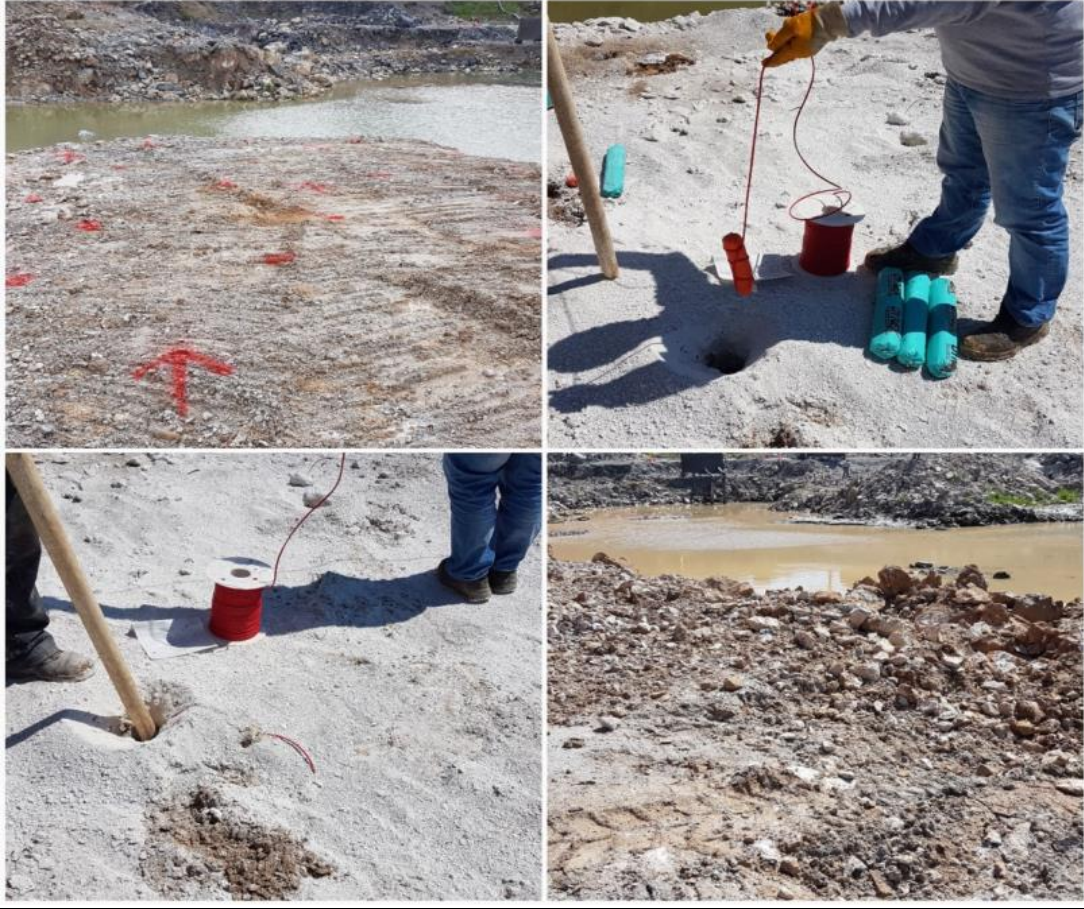
Şekil 5. 14: Patlatma Bölgesi-4 (Ön Hazırlık, Emulite ve Sulu Anfolar, Sıkılama, Patlatma Sonrası Taş Fırlamaları).
