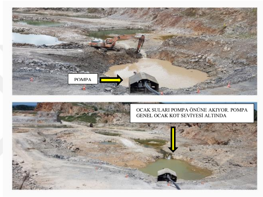
Şekil 5.5: Pompa Önü 2.Kısım Çalışması Sonrası Son Hali.
