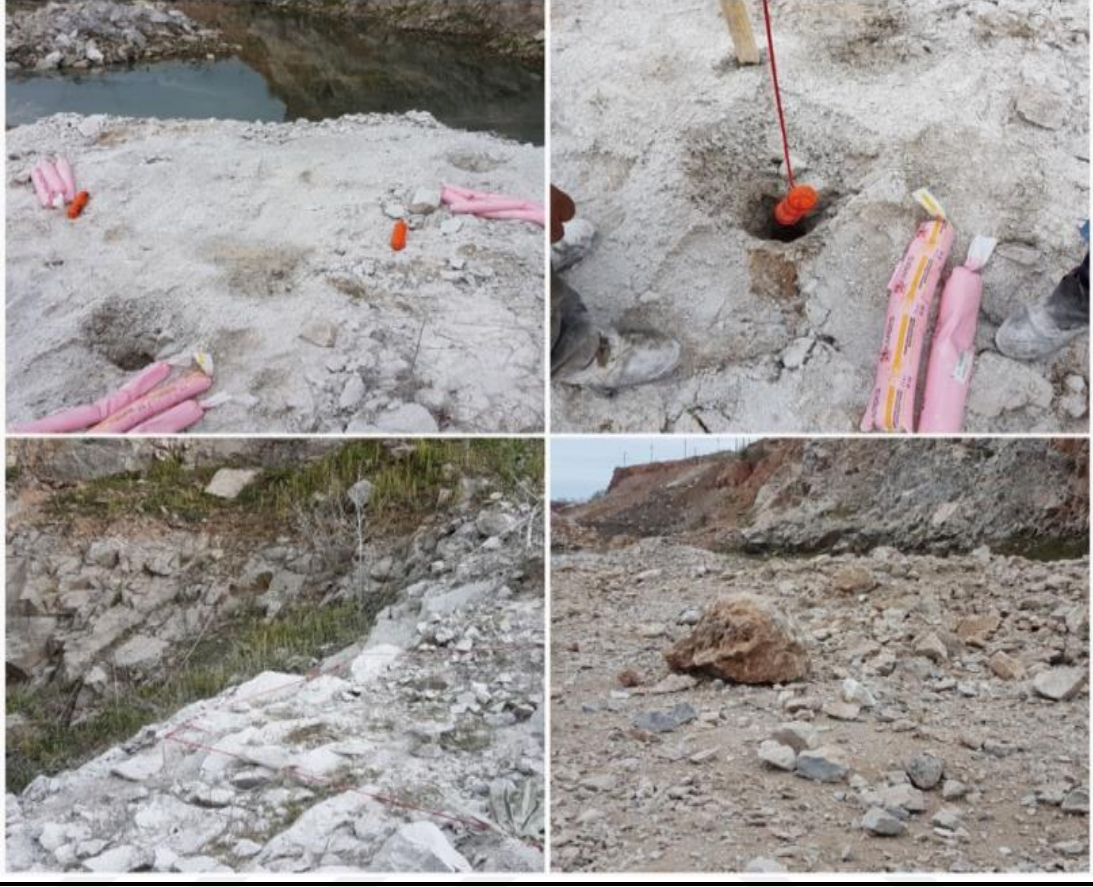
Şekil 5.12: Patlatma Bölgesi-2 (Delikler, Şarjlama, Bağlantı ve Fırlayan Taşlar).
