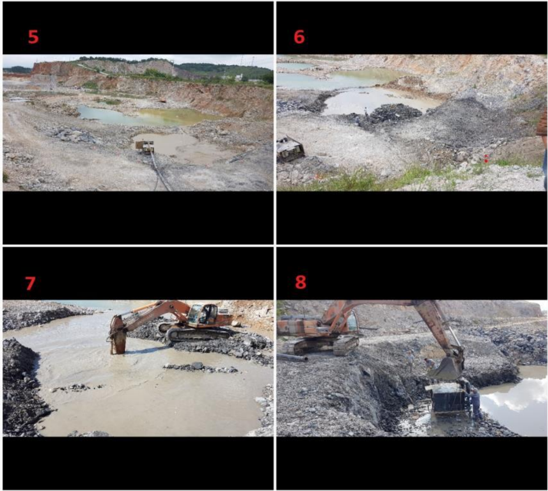
Şekil 5.4: Ocak İçi Suyu 2. Kısım Tahliye Çalışması İşlem Sırası Görüntüsü.
