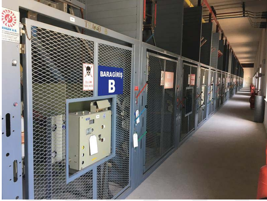
Şekil 10 Açık Tip Orta Gerilim Hücreler
