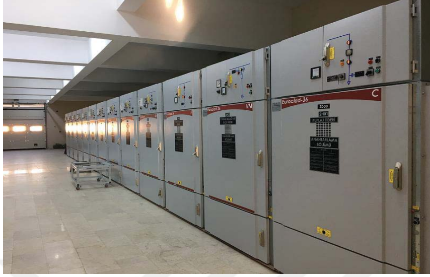
Şekil 11 Metal Muhafazalı Moldüler Hücreler
