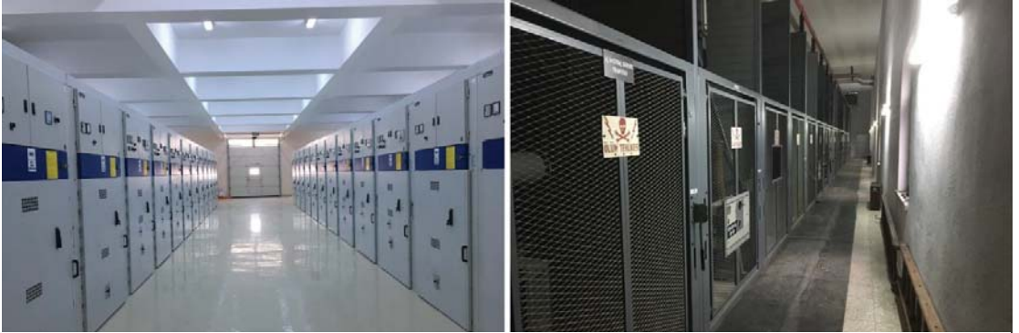
Şekil 13 Yeni ve Eski Tip Dağıtım Hücreleri
