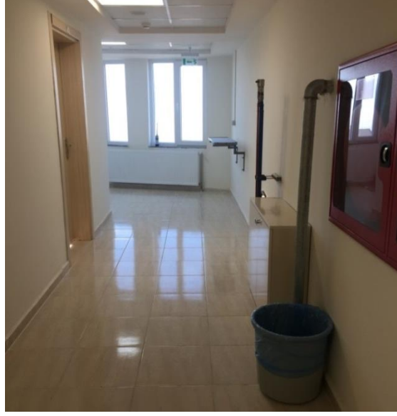
Şekil 35 Kaçış yolunu sınırlandıran elemanlar
