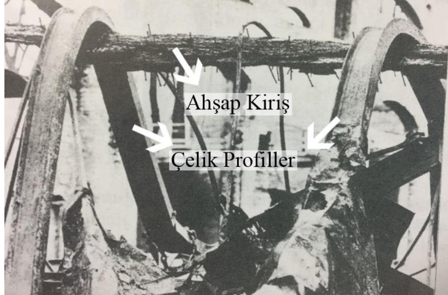
Şekil 14 Bir yangın sonucu ahşap ve çeliğin yangına gösterdiği direnç [77]
