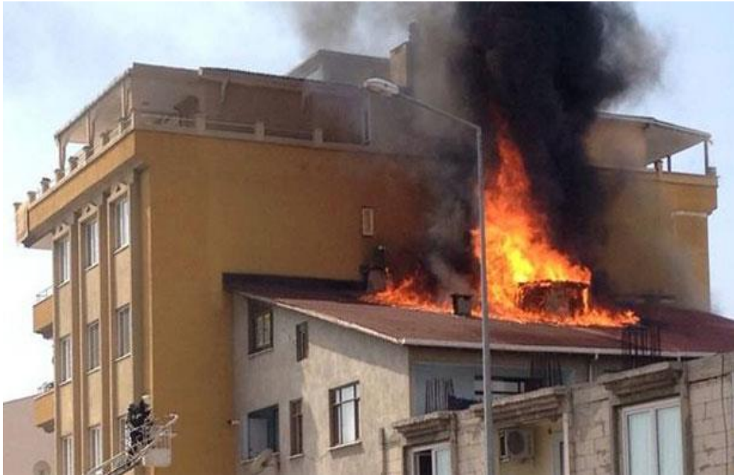
Şekil 16 Bitişik nizamda bulunan bir binanın çatısında meydana gelen yangın
