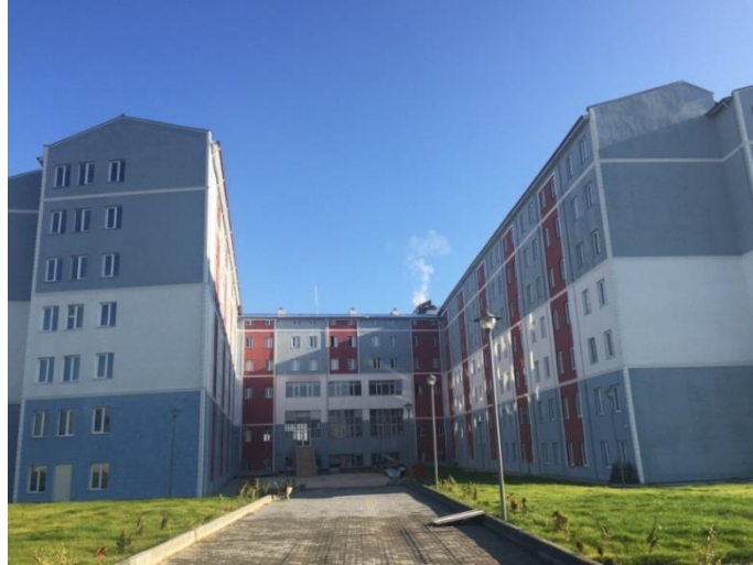
Şekil 36 Batı cephesine ait görünüm
