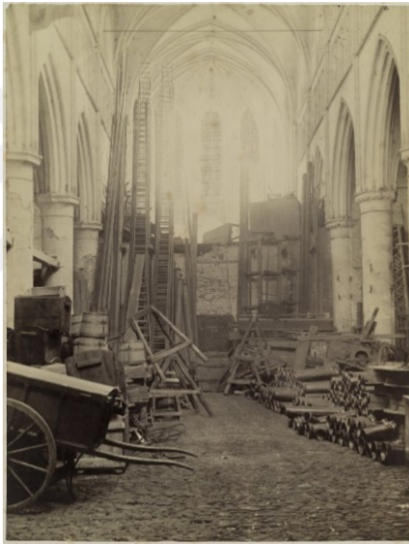
Figure 17 a. Warehouse transformation (Source: Rijksdienst voor het Cultureel Erfgoed, 1884)
