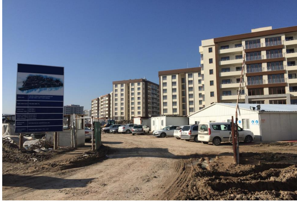
Şekil 8 Şantiye Giriş Tabelası
