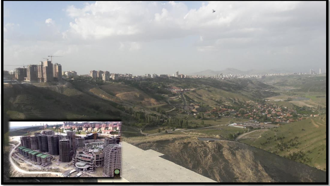
Fotoğraf 5.24 “Kentsel Dönüşüm Yasası” kapsamında, İmrahor Vadisi’nin yamacına ve tabanına yapılmış ve halen yapılmakta olan lüks konutlar. (Başkent Konutları)
