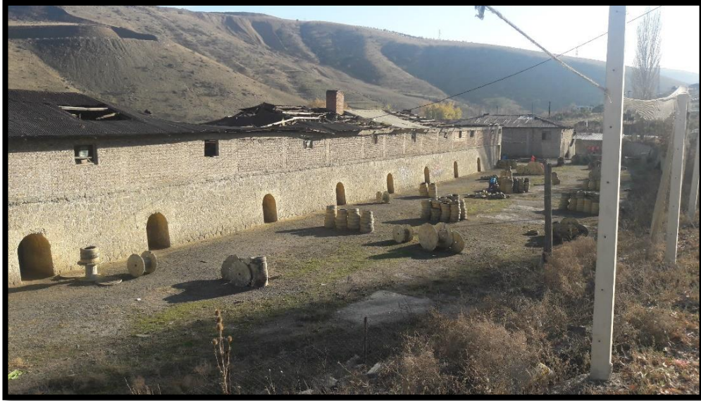
Fotoğraf 5.31 İmrahor Vadisinde yıkılmış olan tuğla fabrikası (eski kullanımı paintball alanı)
