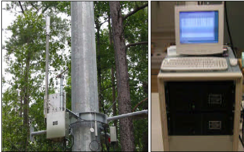
Şekil 1.5. Algılayıcılar ve Ana İstasyon Bilgisayarı ( http://www.climatronics.com./Systems/LLWAS )
