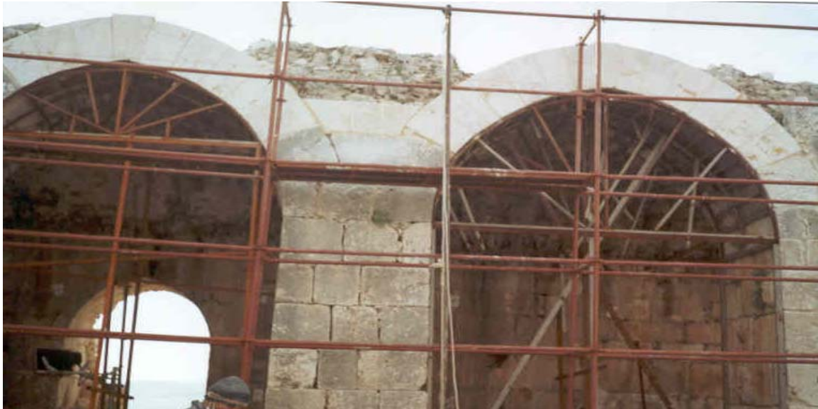
Mersin Kızkalesi Arkad Onarım Aşaması (Resim-28)
