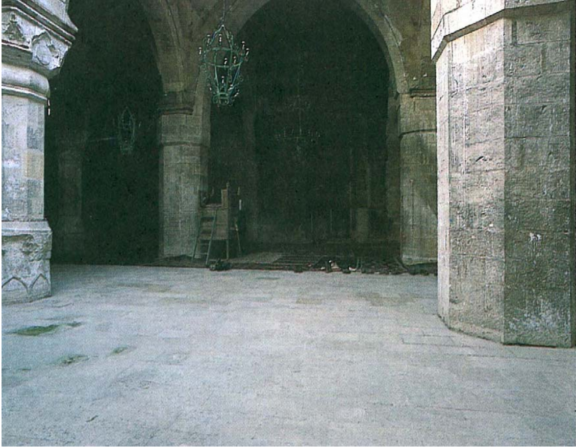
Divriği Ulu Camii Şifahanesi Mantolamayla güçlendirilmiştir. ( Resim- 42)
