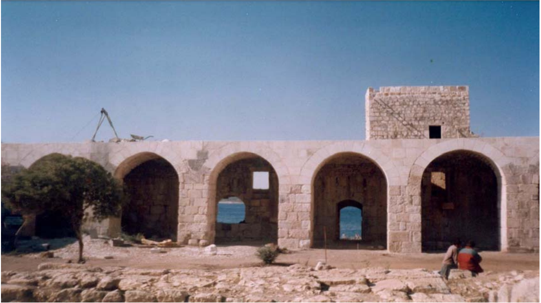
Kızkalesi Arkad Onarım öncesi ve Onarım Sonrası ( Resim- 46)
