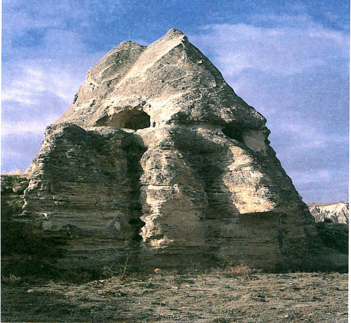
Göremede El Nazar Kilisesi Cephesinde Taş Bozulmalar ( Resim- 18)
