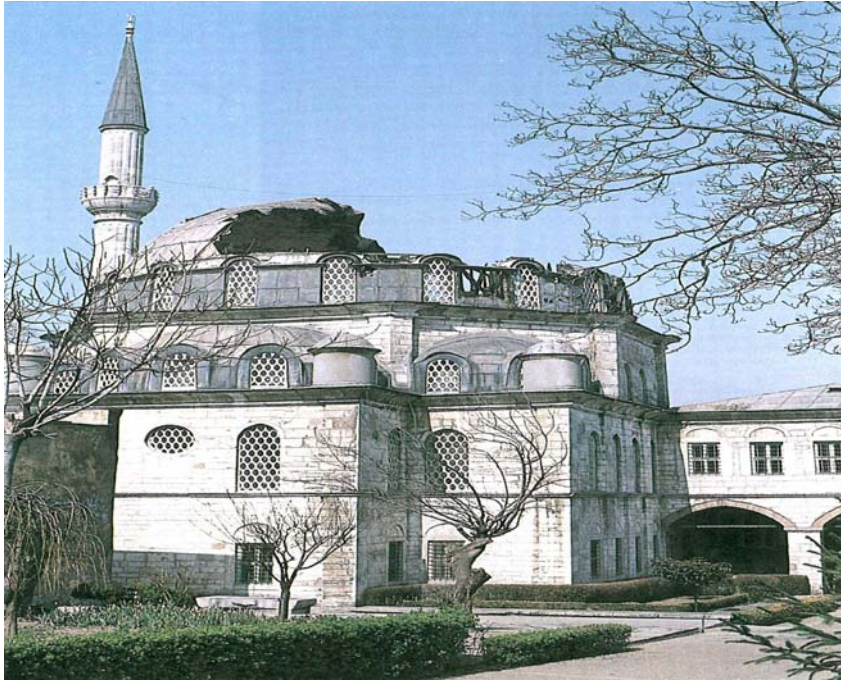
Beylerbeyi Camii Yangın Sonrası Tamamlanan Kubbesi ( Resim- 44)
