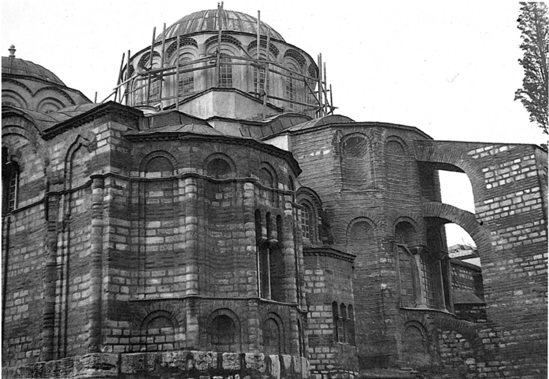
Vitali Kilisesi Duvarlarını destekleyen payandalar ( Resim- 41)
