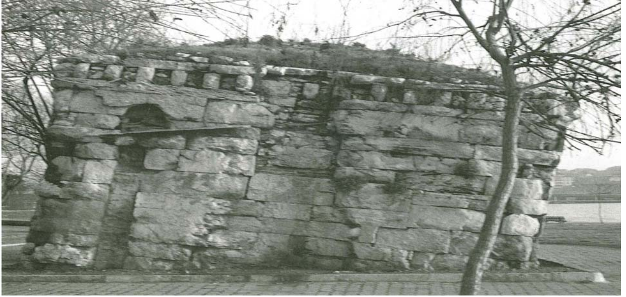
Galata'da (1732 )tarihi Kethüda Yahya Ağa Çeşmesinin Haliç'e doğru yatmış hali (Resim- 14)
