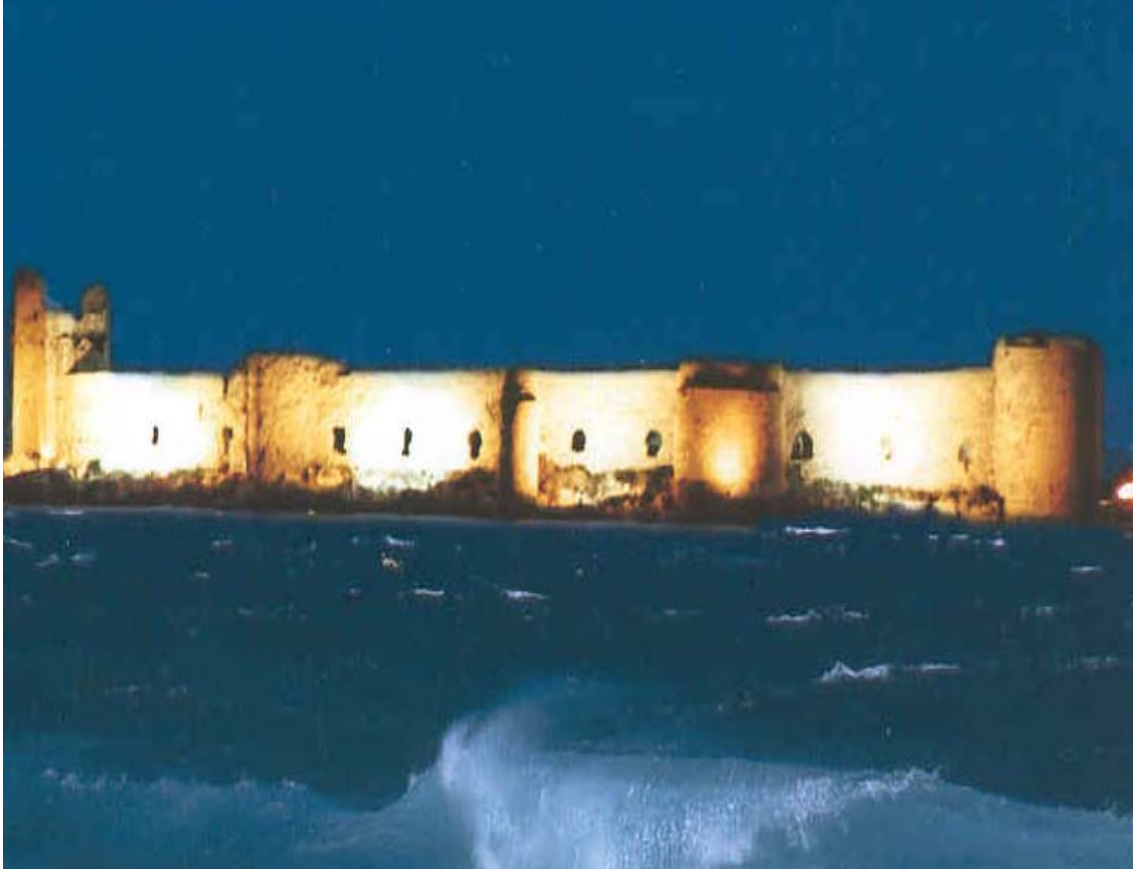
Korikos Kalesi (Sur Duvarlarında ki bozulmalar tespit ediliyor.) (Resim- 35)
