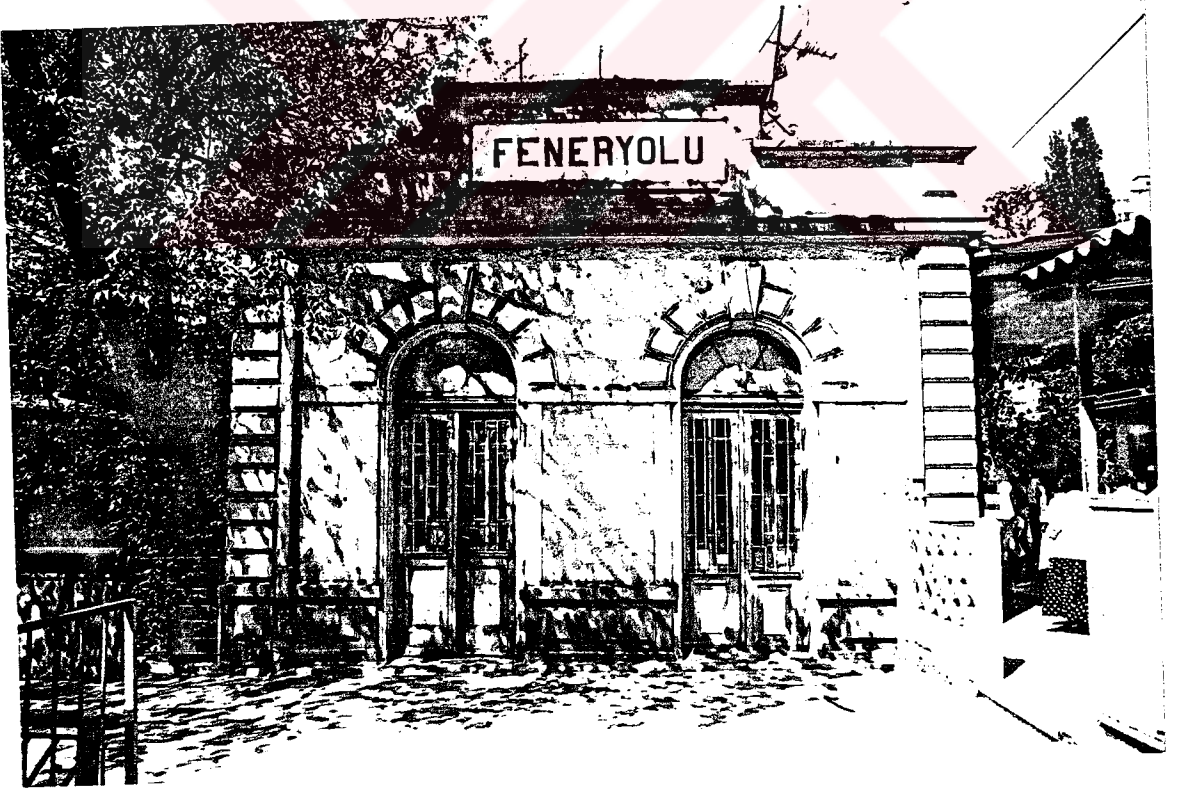
Foto.4.3.2 Feneryolu Tren İstasyonu Yan Cepheden Görünüm
