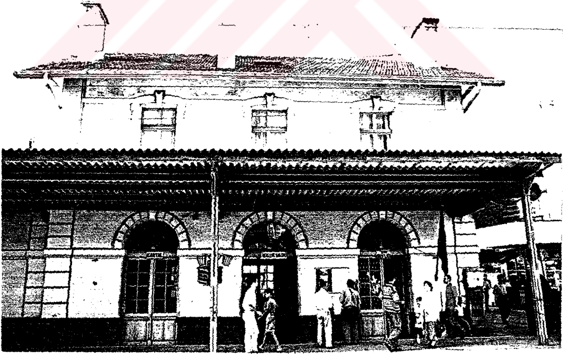
Foto.4.9.2 Kartal Tren İstasyonu Ön Cepheden Görünüm
