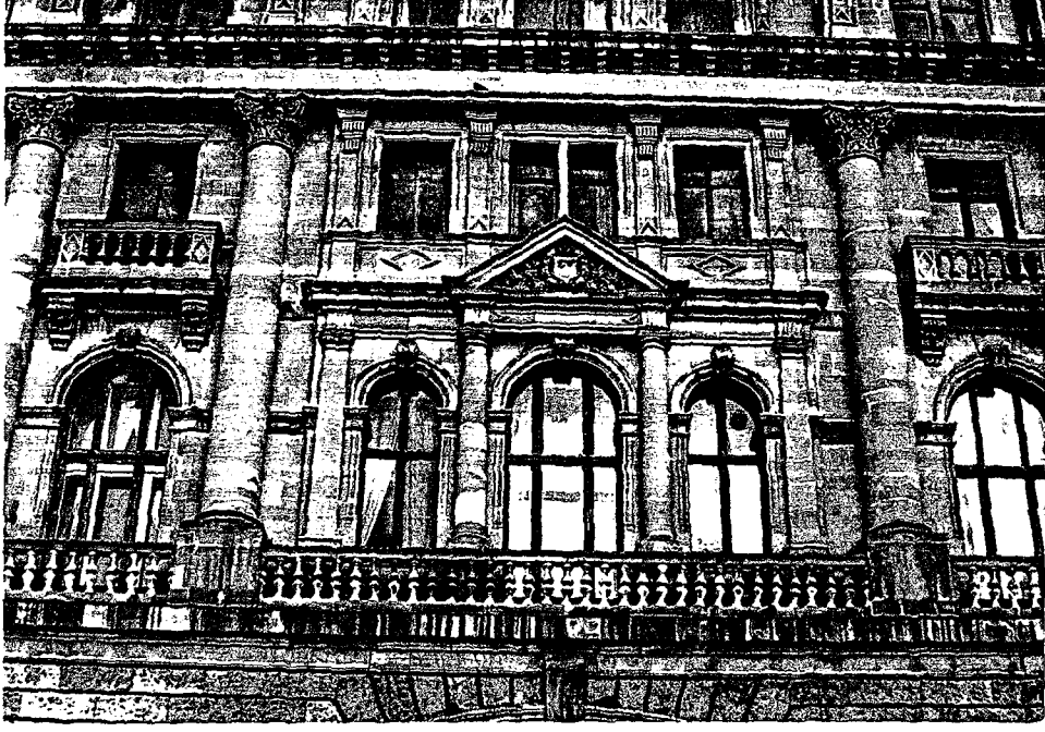
Foto.4.1.15 Güney Cephesi İkinci Kat Detay
