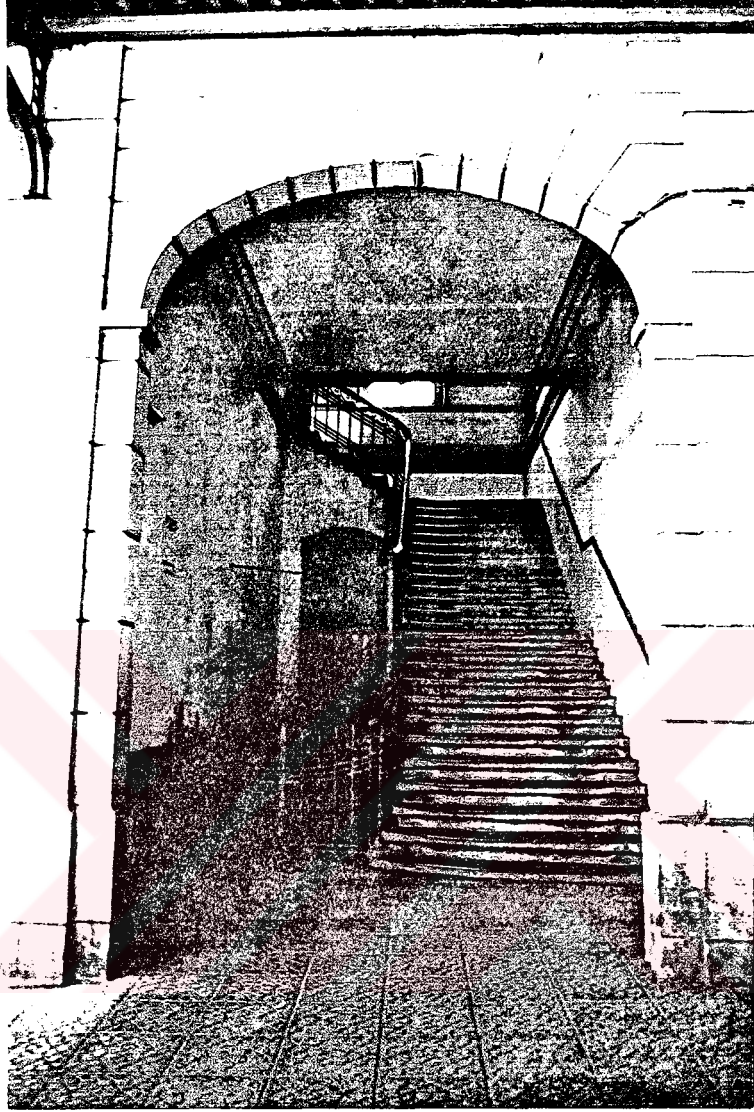
Foto.4.4.6 Gztepe Tren İstasyonu Merdivenleri
