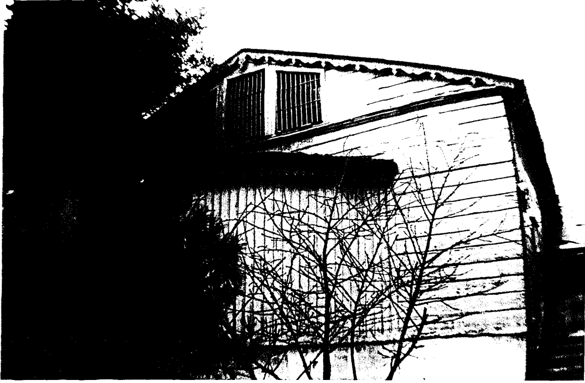
Resim 38.1 Ayios Yeoryios Kilisesi ( Bakırköy ) Dış Cephesi
