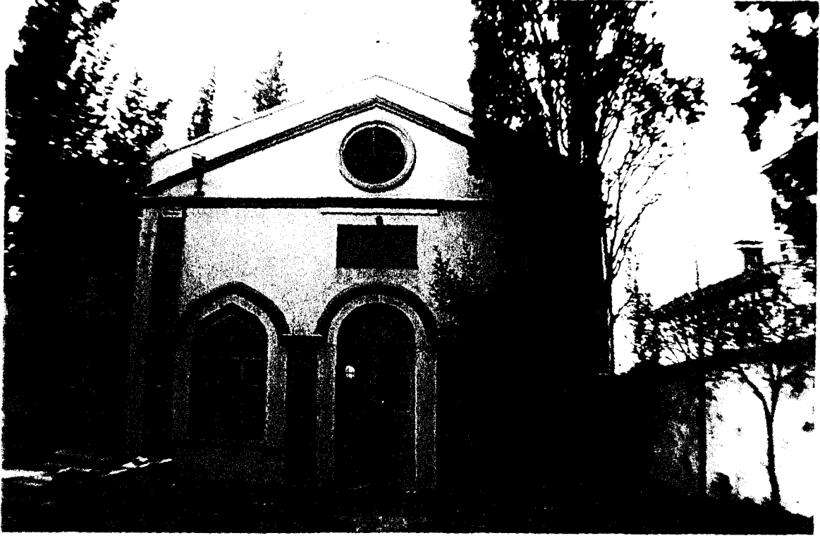
Resim 2.1 Analipsis Kilisesi (Bakirköy) Batı cephesi
