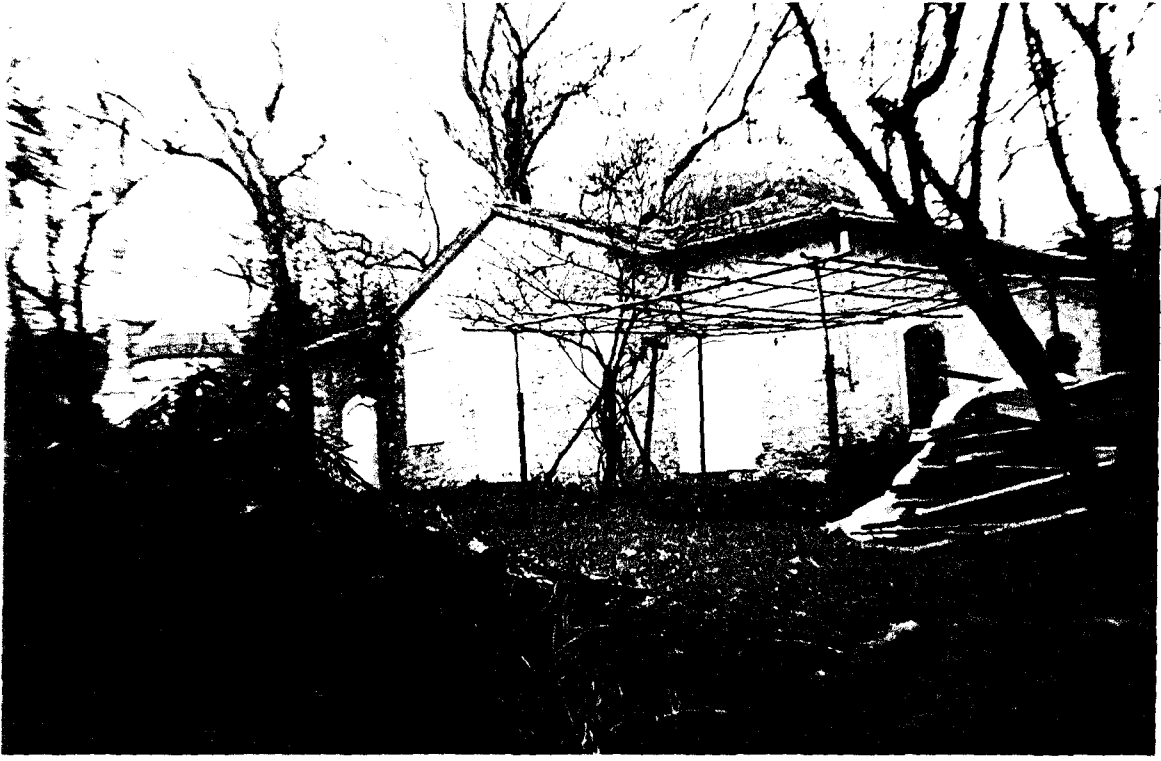
Resim 64.1 Profiti İlia Kilisesi (Arnavutköy) Dış Mekan
