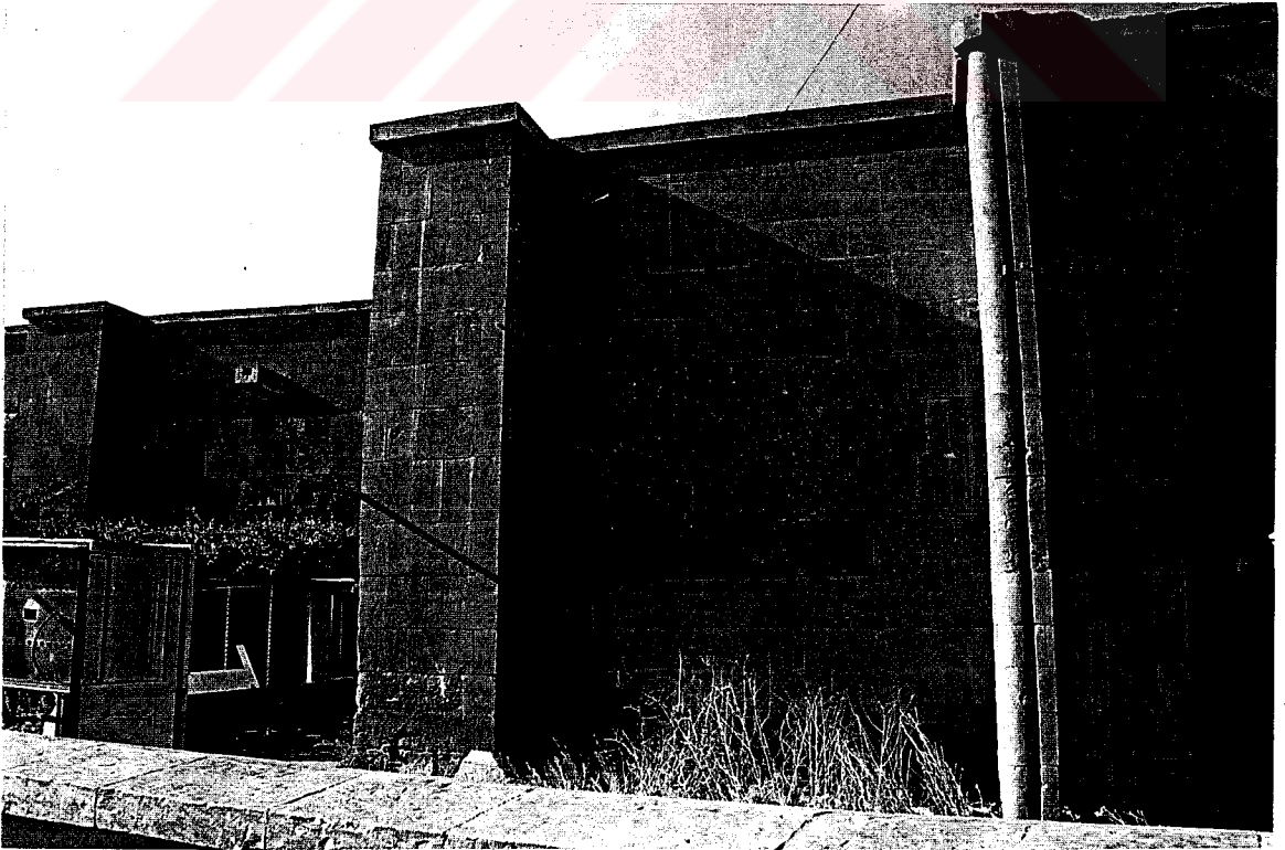
Şekil.2.359. Kesikköprü Kervansarayı, Mescit, Güney cephe
