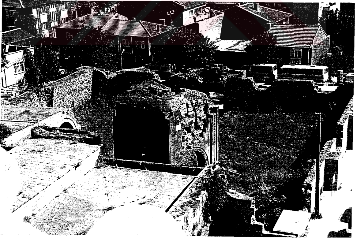
Şekil.2.308. İshaklı Kervansarayı, Köşk Mescidin Avludaki Konumu
