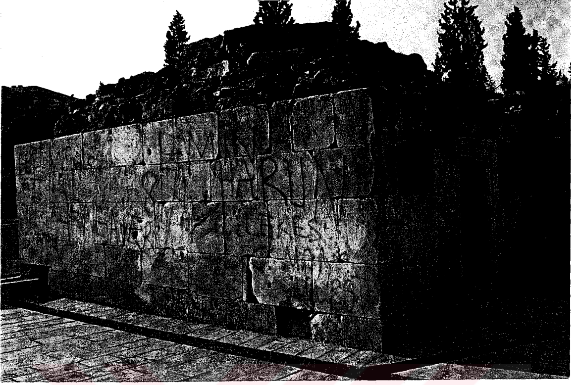
Şekil.2.345. Ak Han, Mescit, Güneydoğu Cephe
