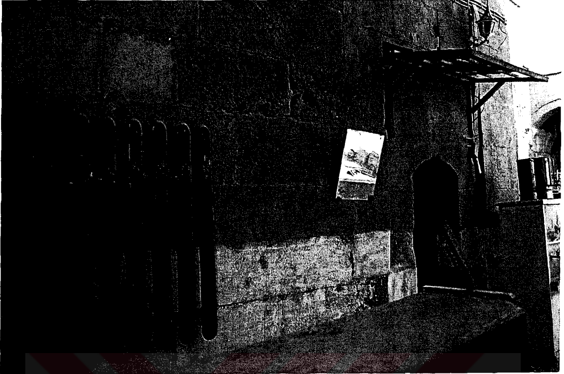
Şekil.2.360. Kesikköprü Kervansarayı, Mescit, Doğu Cephesi
