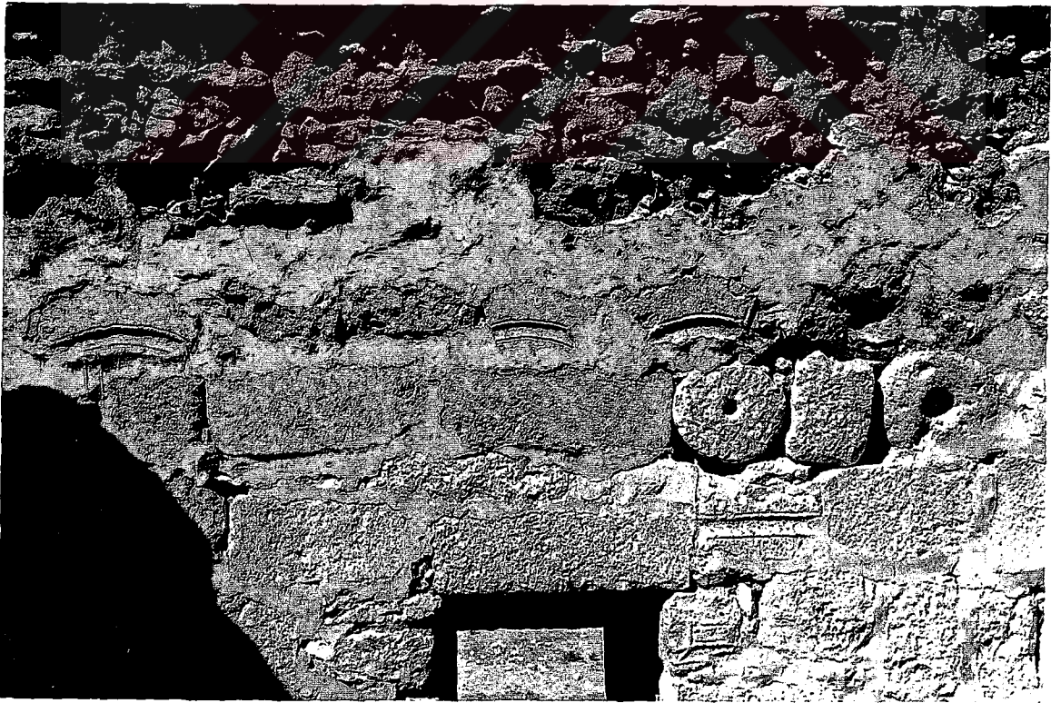
Şekil.2.36. Mescidin Batı Cephesinde Devşirme Malzemeler
