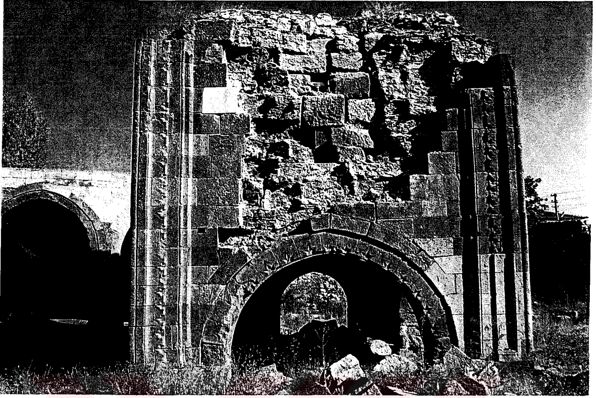
Şekil.2.311. Köşk Mescit, Güney Cephe
