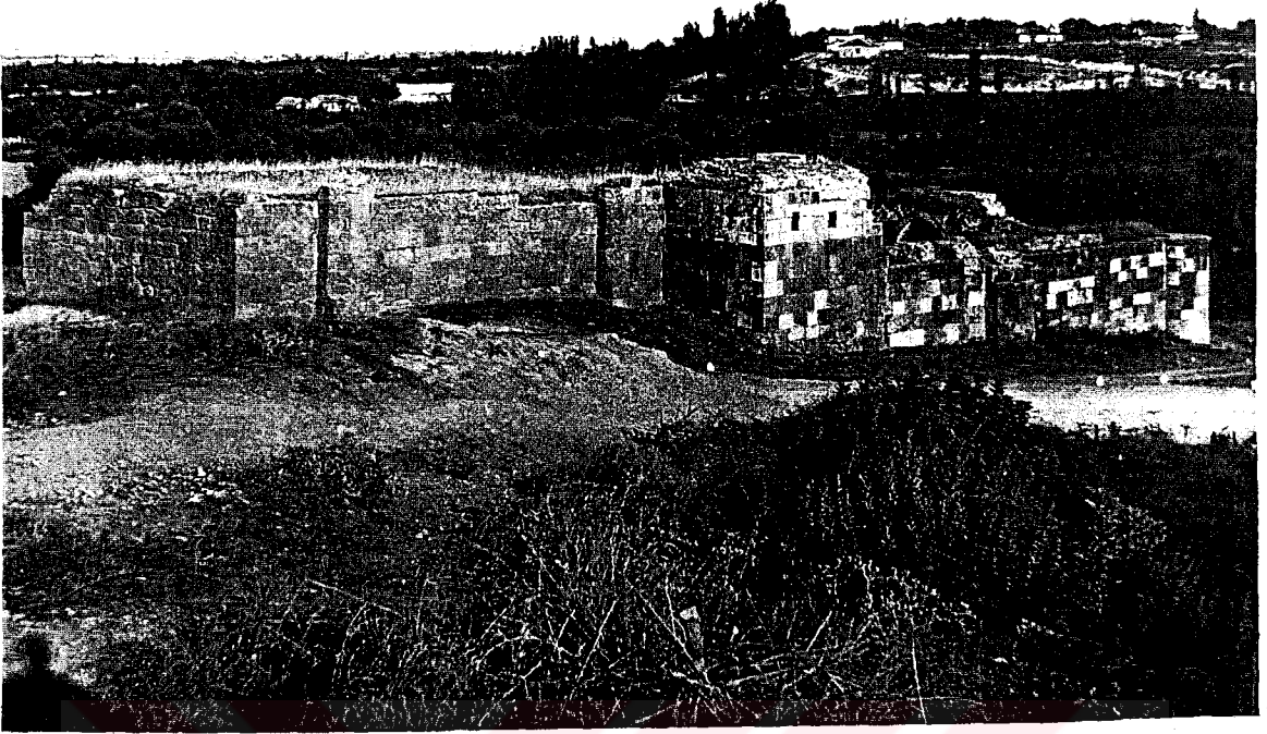
Şekil.2.337. Ak Han Güneybatı Cepheden Görünüş (Oktay Aslanapa Arşivi)
