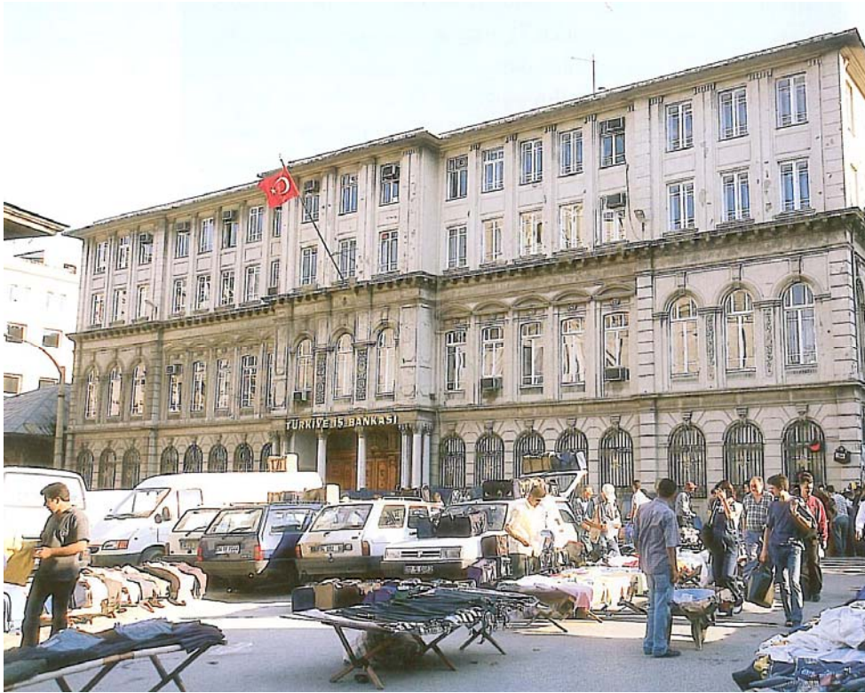
Şekil 4.8 : Türkiye İş Bankası Yeniceami Şubesi dış görünüşü (Koçak, O., 2001, s.251).
