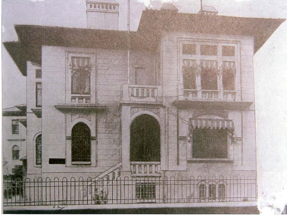
Şekil 4.2 : Türkiye İş Bankası ikinci genel müdürlük binası (Koçak, O., 2001, s.15).
