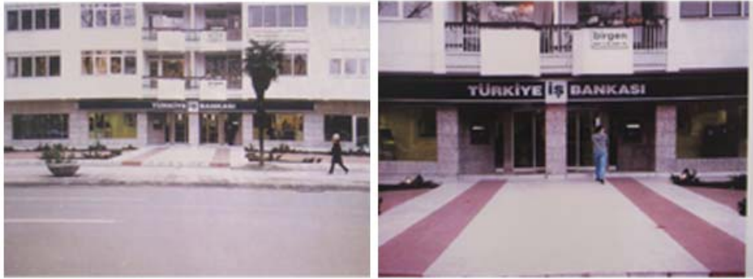
Şekil 4.29 : Türkiye İş Bankası Caddebostan Bireysel Şubesi giriş cephesi (Türkiye İş Bankası SistematiK Şube Tasarımı Kılavuzu, 1999).
