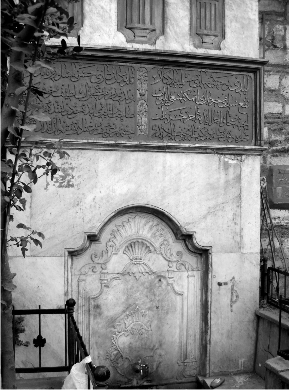
Şekil B.19 : Kaptan Gazi Hasan Paşa Çeşmesi, 1780, Kasımpaşa.
