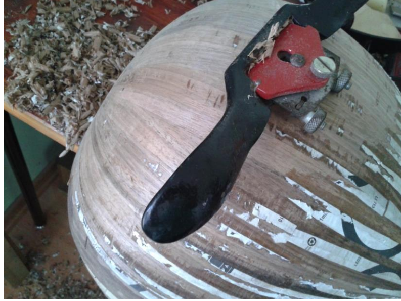
Şekil 4.18 : Tekne dışının tesviye edilmesi
