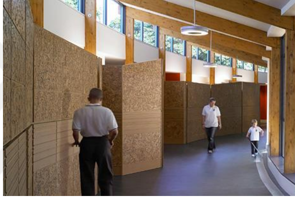
Şekil 3.20: Koridordaki kaplama malzemeleri, duvarlarda ve zeminde çıkıntılar.
