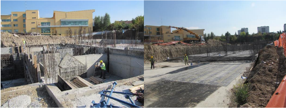
Şekil 5.2: SERÇEV Engelsiz Meslek Lisesi projesinin inşaat çalışmaları, Temmuz 2015.
