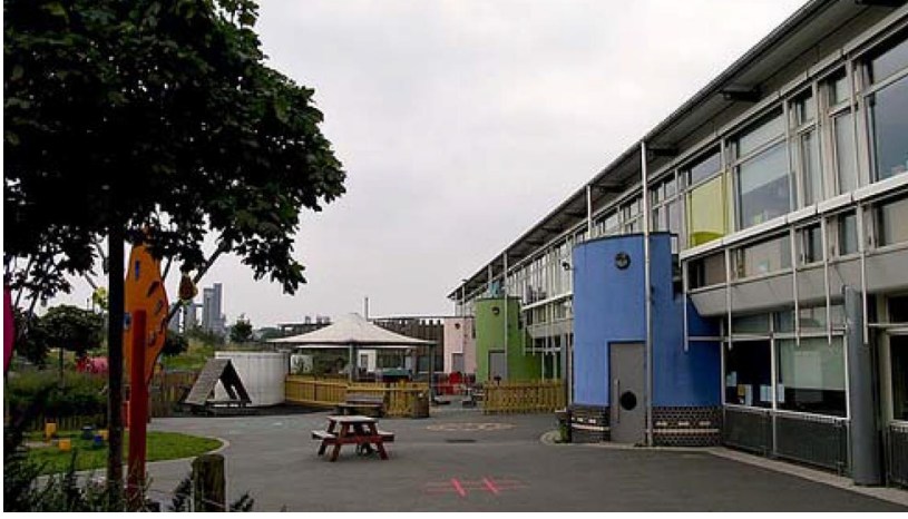
Şekil 3.16: Millenium Primary School okul binası.
