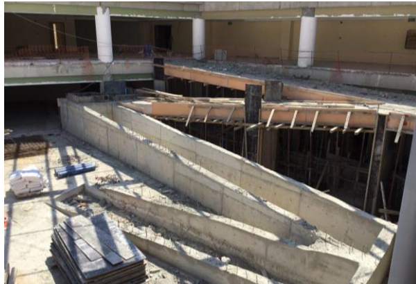
Şekil 5.9: İnşa edilen 4 kollu rampa.
