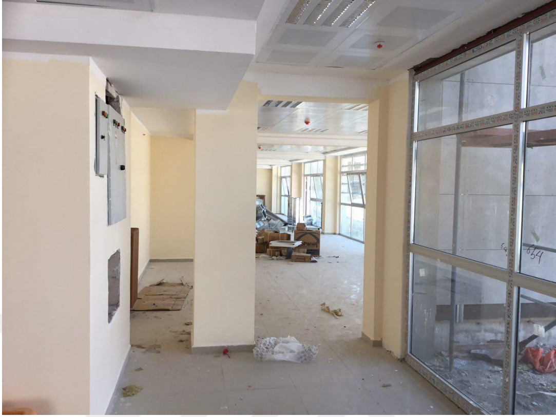
Şekil 5.16: İnşa edilen yemekhane.
