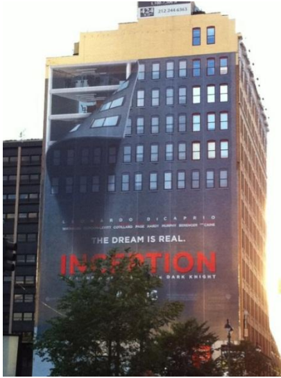
Şekil 2. 5. Bina Giydirme Çalışması 124
