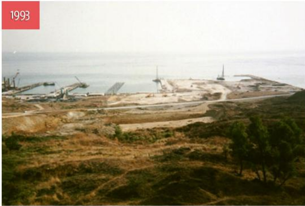
Şekil.19. Altaş Ambarlı Limanının 1993 Yılındaki Durumu 66
