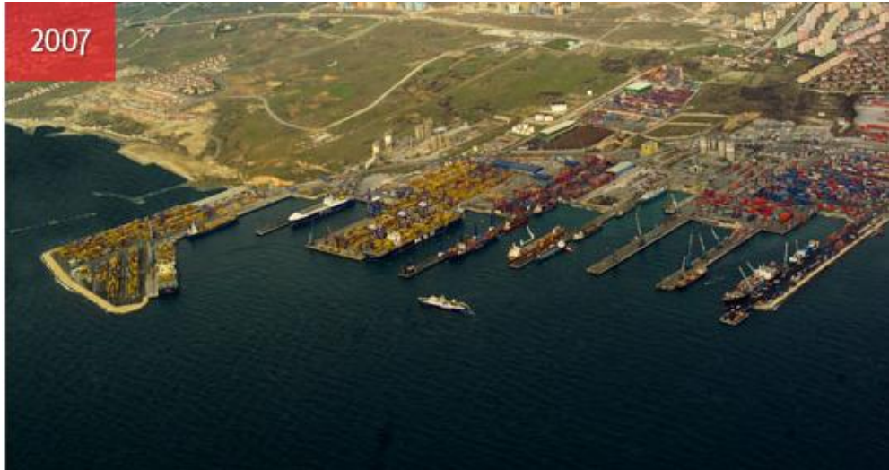
Şekil.20. Altaş Ambarlı Limanının 2007 Yılındaki Durumu 67
