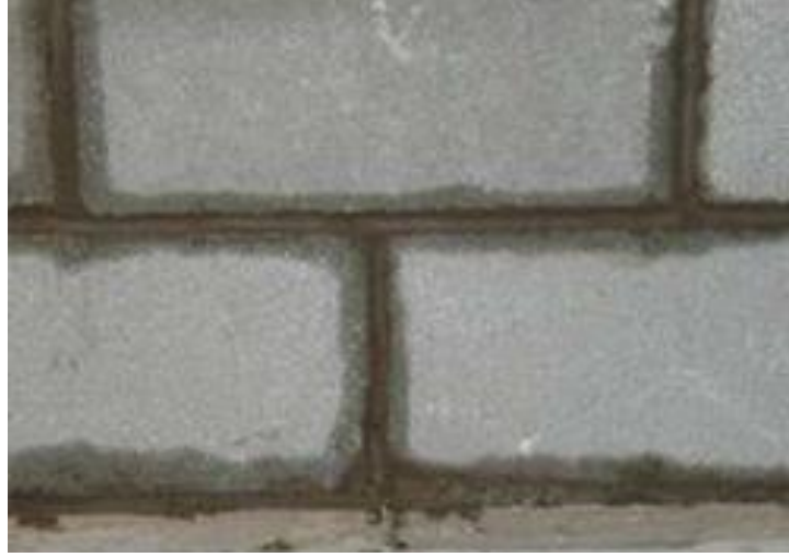
Şekil 4-2 Çimento harcı kullanılarak inşa edilen beton inşa edilen beton
