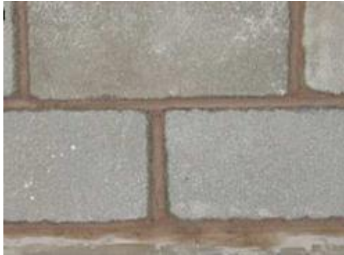
Şekil 4-3 Kireç harcı kullanılarak inşa edilen beton inşa edilen beton.
