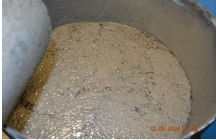
Şekil 3.3 Malzemenin betoniyerde karıştırılması
