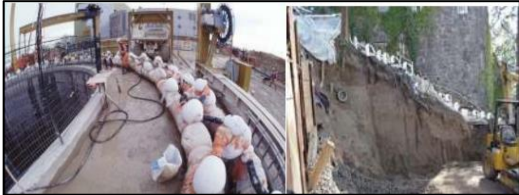
Şekil 1.31 Tünel shaftı ve zorlu bir şevin kontrolünde zeminin dondurulması
