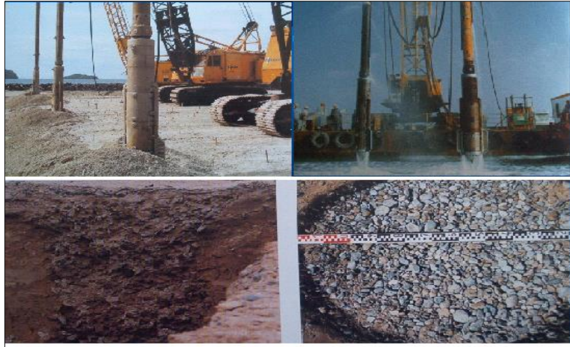
Şekil 1.17 Taş kolon imalatı genel görünüm(URL8)
