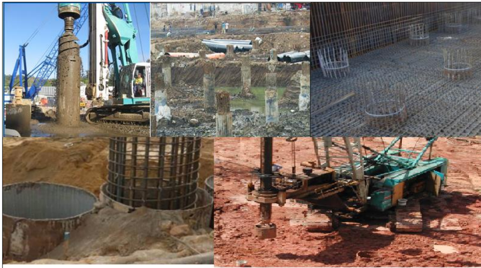
Şekil 1.20 Fore kazık imalatları
