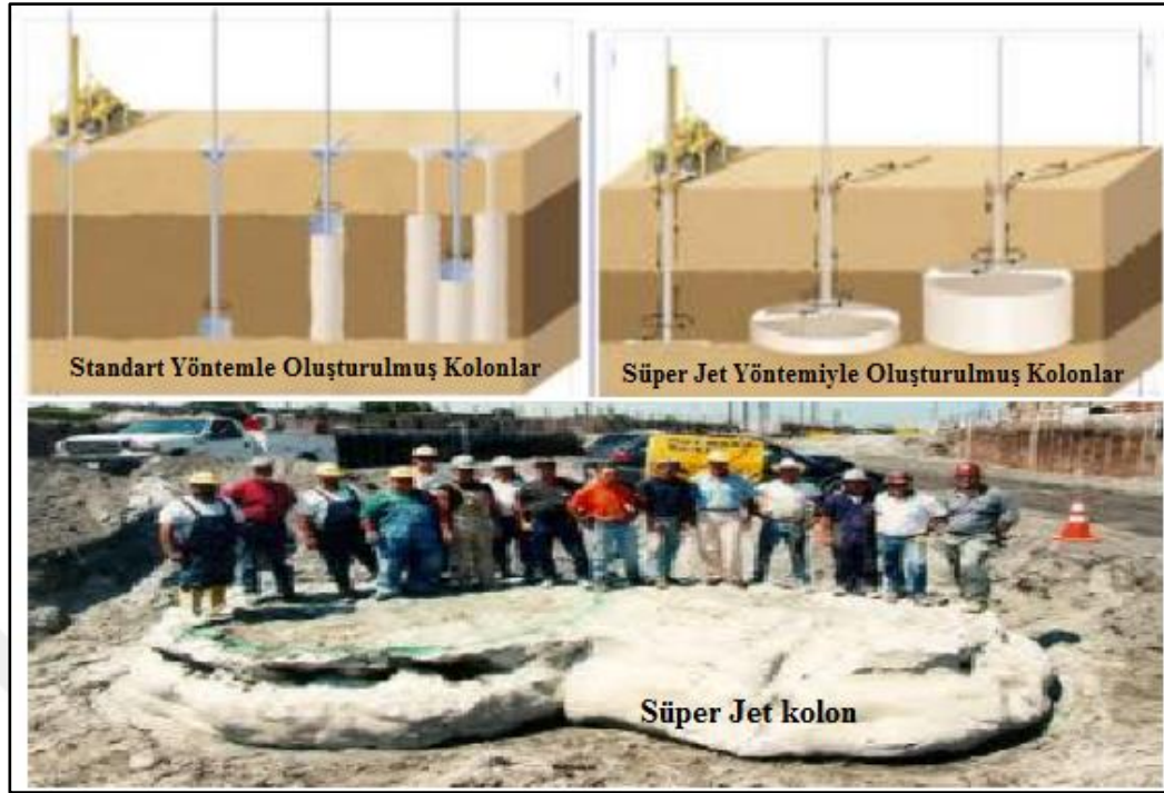
Şekil 1.48 Süper jet yöntemiyle ve standart yöntemle oluşturulan kolonlar
