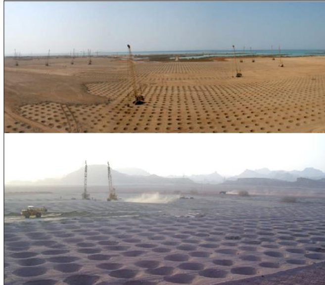
Şekil 1.6 Ağır yüklerin belirli yükseklikten düşürülmesi ile yapılan dinamik kompaksiyon örnekleri (Kral Abdullah Üniversitesi, Arabistan)
