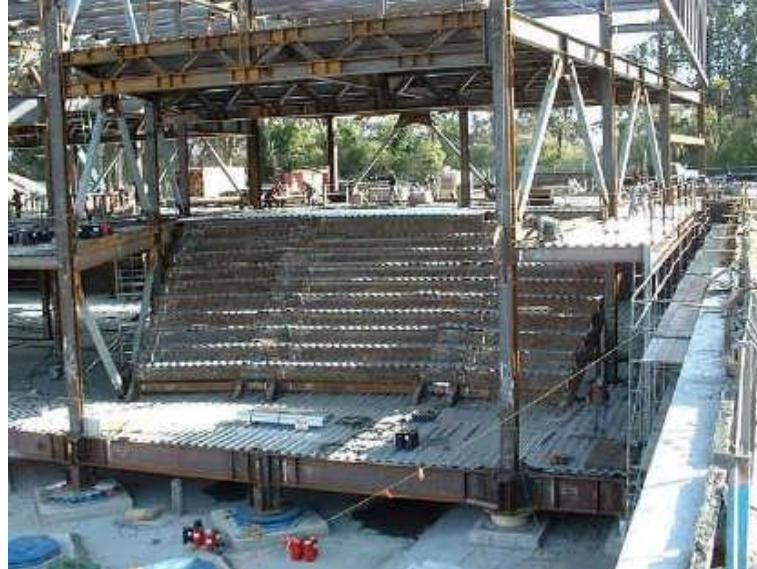
Şekil 5.25 Çelik yapıda karma sistem-Dış kolon altlarında kauçuk esaslı, iç kolon altlarında sürtünme esaslı izolatör (Ofraz, 2013)
