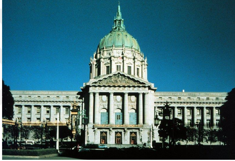
Şekil 5.13 San Fransisco Belediye Binası
