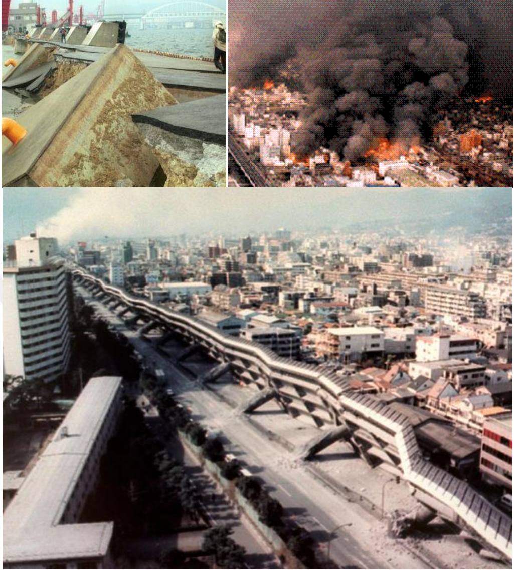
Şekil 6.42 1995 Japonya-Kobe depremi hasarı
