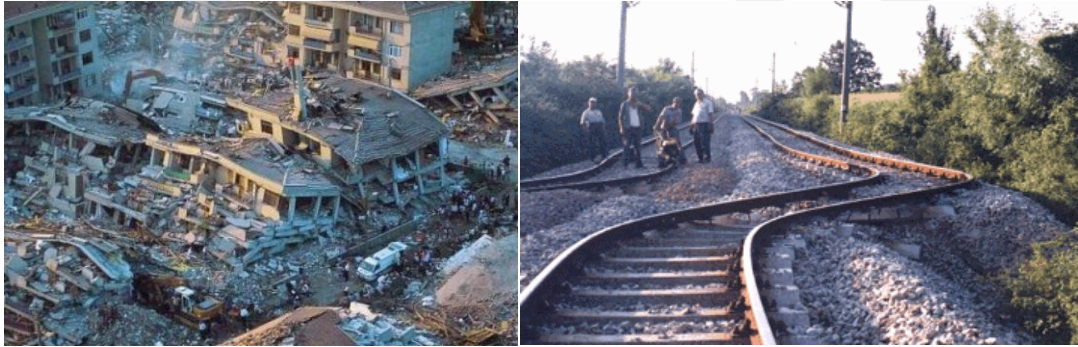
Şekil 6.9 17 Ağustos 1999 Kocaeli depremi hasarı
