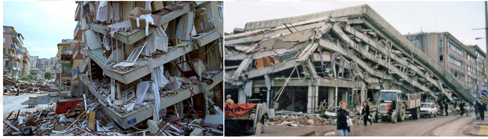
Şekil 6.17 1999 Düzce depremi hasarı
