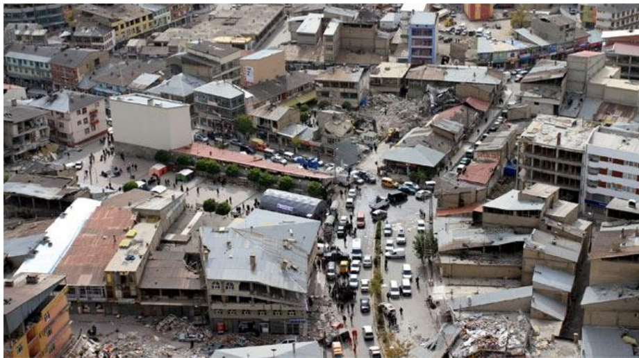
Şekil 6.25 23 Ekim 2011 Van-Erciş depremi hasarı
