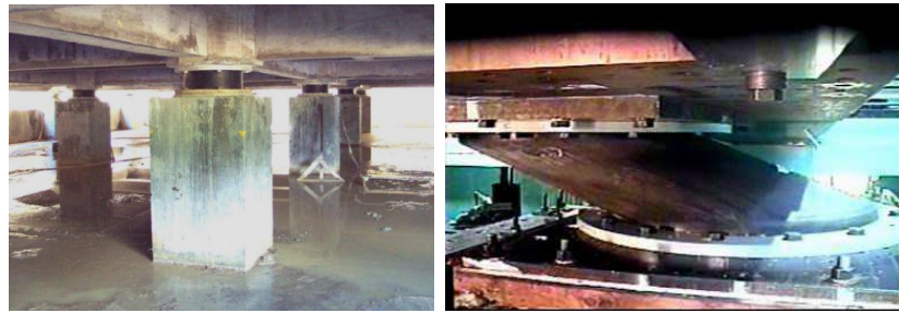
Şekil 5.10 Kauçuk esaslı kurşun çekirdekli kauçuk izolatör (Oflaz, 2013)
