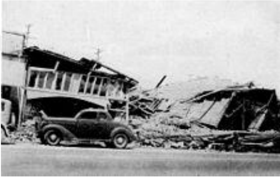
Şekil 6.33 1940 El Centro depremi hasarı
