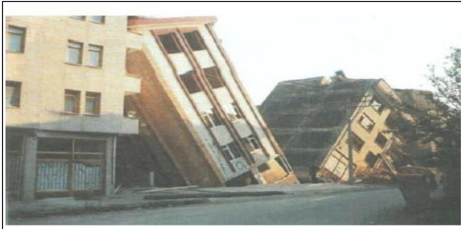
Şekil 2.12 Adapazarı 1999 depremi sıvılaşmaya uğramış zeminin yapılar üzerindeki etkisi
