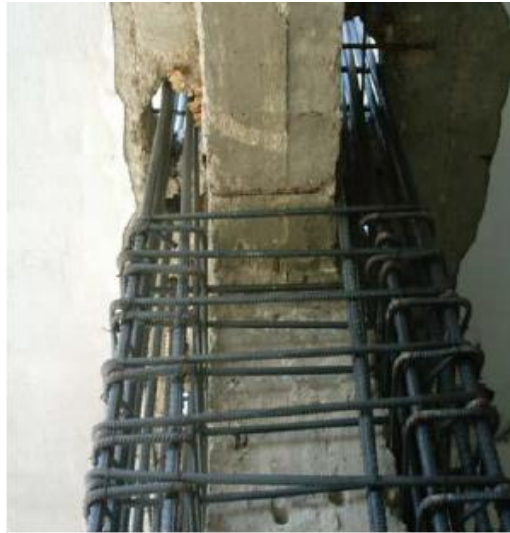
Şekil 2.3 Kolon mantolamasında süreklilik (Batmacı, 2011)
