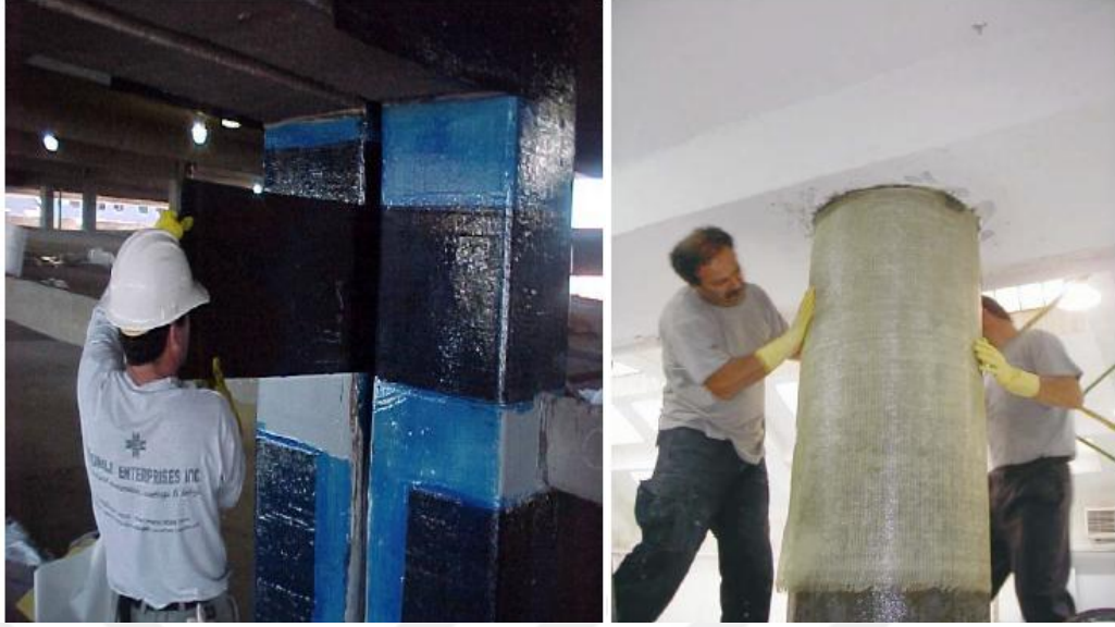
Şekil 1.21 Lifli polimer ile kolon güçlendirilmesi (Yıldırım, 2008)
