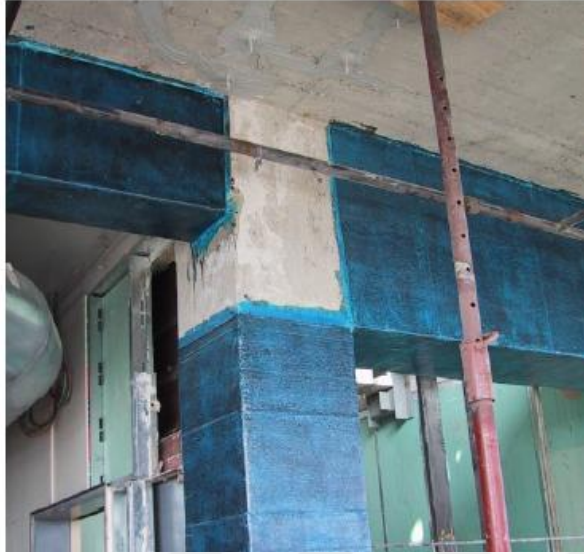
Şekil 1.23 Lifli polimer ile kiriş güçlendirilmesi (Yıldırım, 2008)
