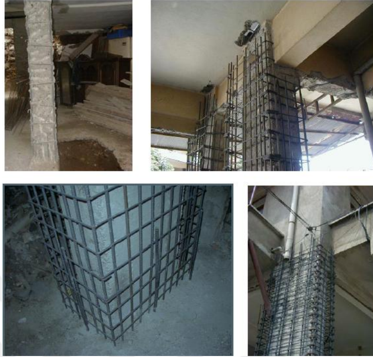
Şekil 2.4 Kolon manto uygulama aşamaları (Altın, 2008)
